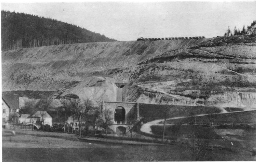
Heutiges Kulturdenkmal "Bahndamm Hirsau" mit Baufeldbahn. Um 1870.
