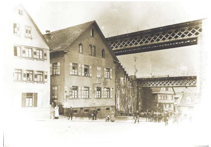
Ziegelbachbrücken der Schwarzwaldbahn (vorn) und der Nagoldbahn, Foto vor 1922 Sammlung Gerhard Buck
