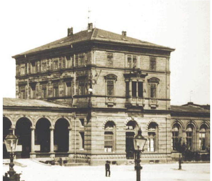
Östlicher Kopfbau des 1874 erbauten Bahnhofs in Heilbronn (1944 zerstört, Foto 1906, Ausschnittvergrößerung) Haus der Geschichte Baden-Württemberg, Sammlung Metz
