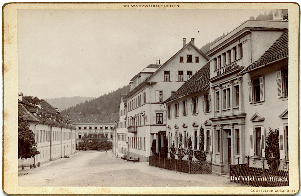
Diese Aufnahme zeigt im Hintergrund das Bad-Hotel und auf der rechten Seite das Hotel Hirsch. Die Aufnahme entstand auf der Zufahrt zum Bad-Hotel in Höhe der Kirche.
