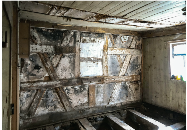
Innenansicht der ehemaligen östlichen Außenwand des Wohngeschosses
