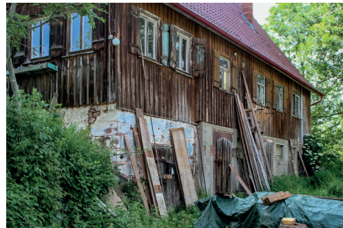
Talseitige Außenwand mit Stall-Zugängen
