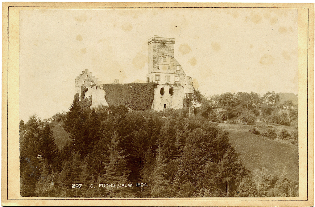
Diese Aufnahme zeigt die Zavelsteiner Burg von der hinteren Seite. Rechts der Burg ist der Zugang zu erkennen. Im Hintergrund, von den Bäumen teilweise verdeckt, sind die letzten Häuser vom „Städle“ zu sehen.
