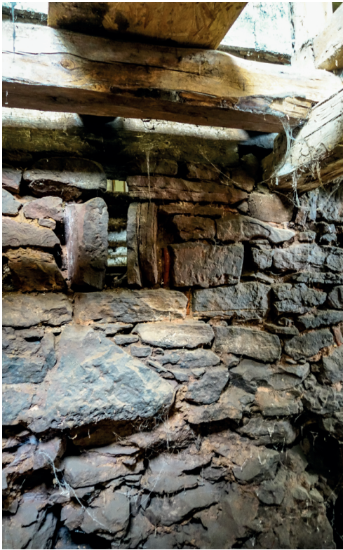
Frühere östliche Außen-Grundmauer mit Schießscharten-artigem Fenster
