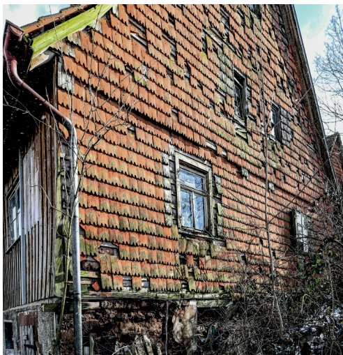
Verkleidete Nordwestfront des Hauptgebäudes
