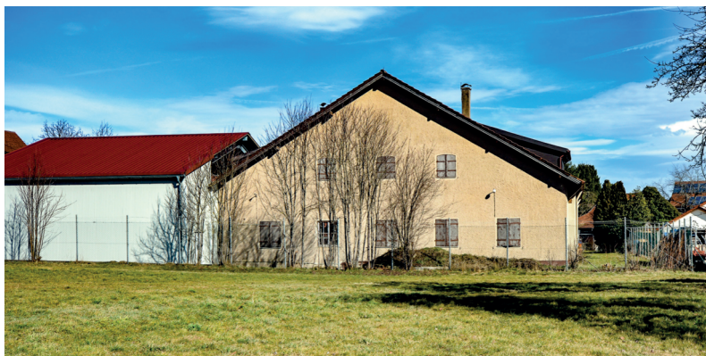
Das Batteriebeständelager der LVZ-Flugabwehrstellung Breitenberg-Oberkollwangen
