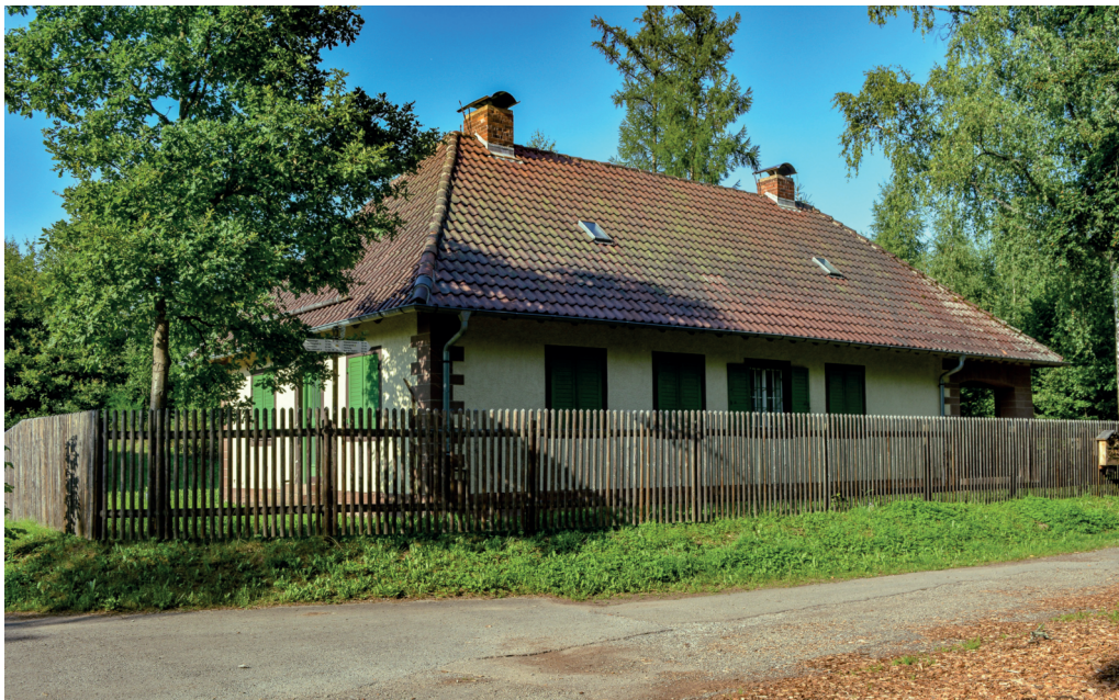
Das Wachgebäude der Munitionsniederlage Althengstett.
