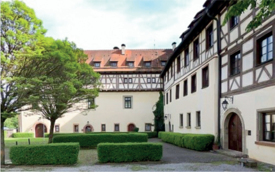
Das Schloss nach Umbau und Sanierung, 1983.
