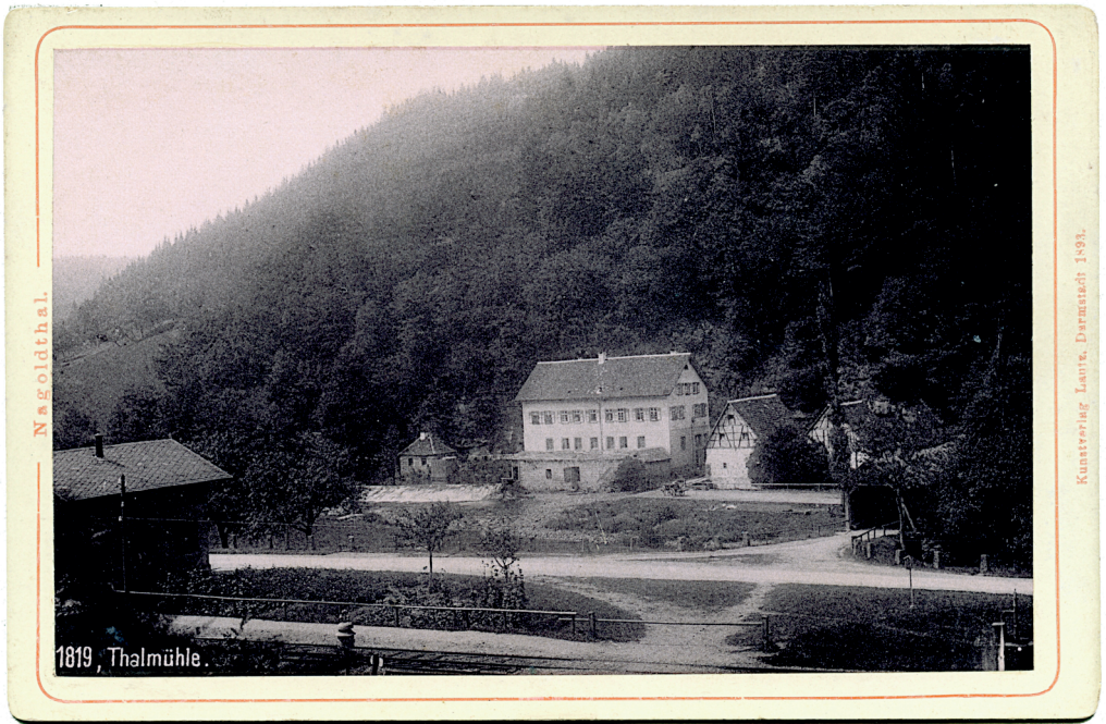
Die Aufnahme zeigt die Thalmühle im Nagoldtal.
