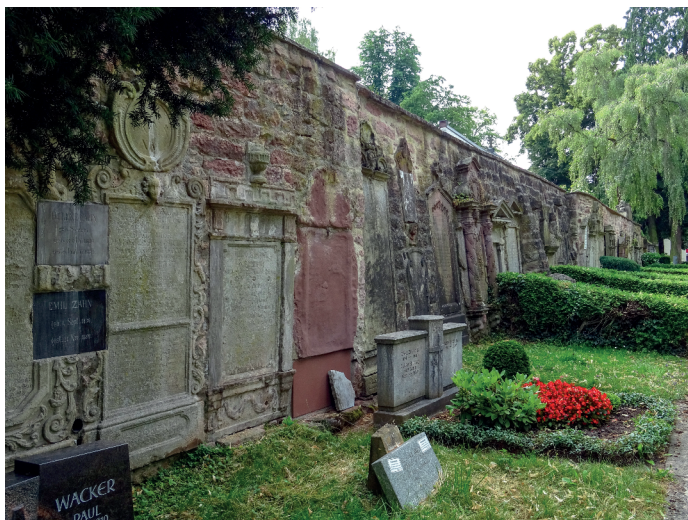
Familiengräber und Epitaphien an der unteren Friedhofsmauer nach der Restaurierung 2004
