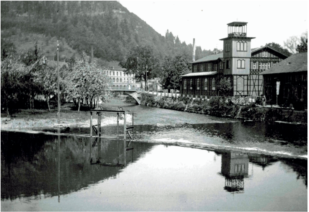
Hinter der Turnhalle Richtung Norden erstreckte sich der „Brühl“, das Calwer Festgelände. Das Foto aus dem Jahr 1913 zeigt den Calwer Norden mit der Turnhalle, deren Turm sich in der Nagold spiegelt, dem Nagoldwehr, der „Kleiner Brühl“ genannten „Insel“, der Unteren Brücke und Gebäuden der Deckenfabrik im Hintergrund.
