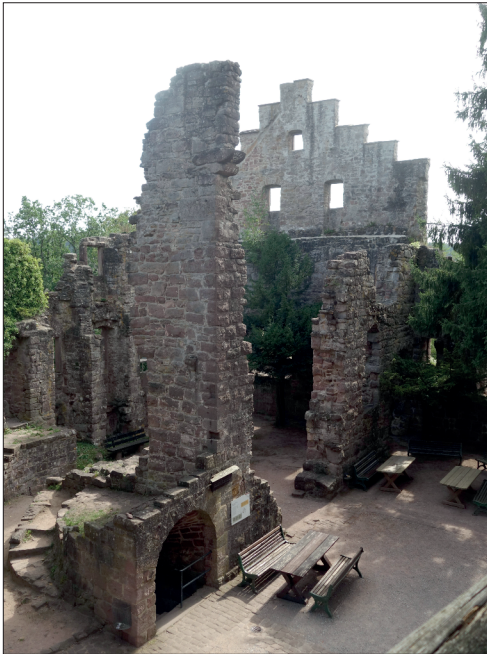
Burg Zavelstein – so genannter Alter Bau, Ansicht von Norden
