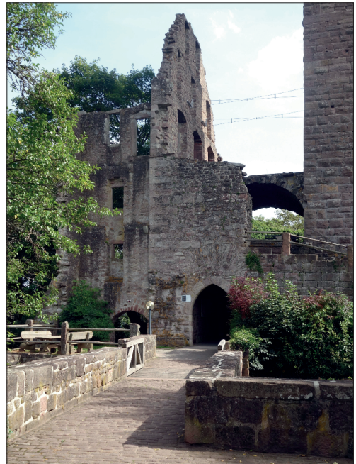
Burg Zavelstein – Ansicht des hochgotischen Burgtors; die Buckel auf den Steinen der Torlaibung wurden nachträglich abgearbeitet, links die Reste des unter Schickhardt angefügten Eckturms.
