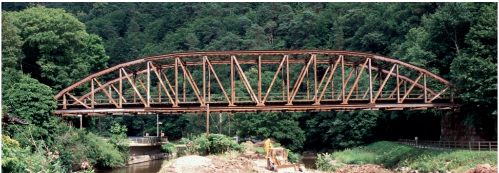
Längsansicht der Nagoldbrücke
