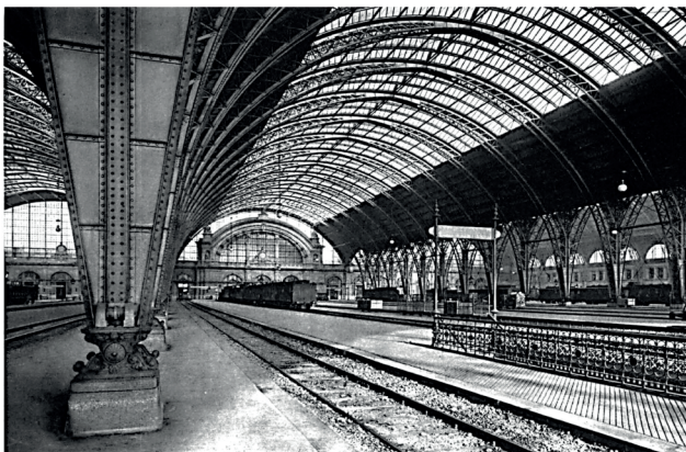
Bahnsteighalle Hauptbahnhof Frankfurt/Main
