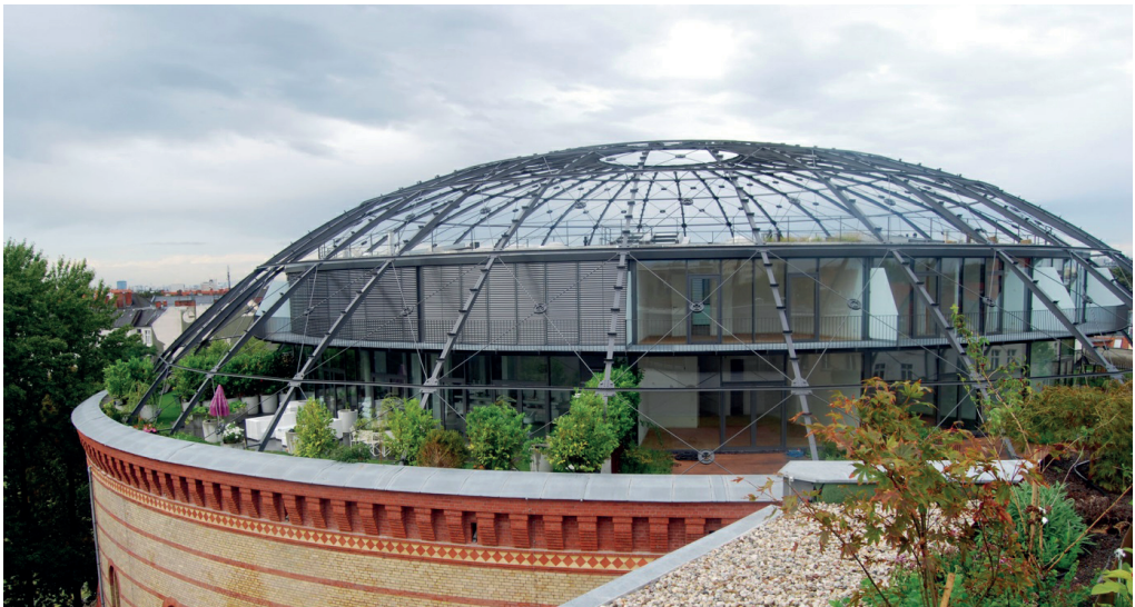
Schwedler-Kuppel auf umgenutztem Gaspeicher
