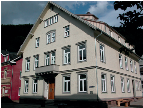
Der Schwanen nach der Renovierung (2015)
