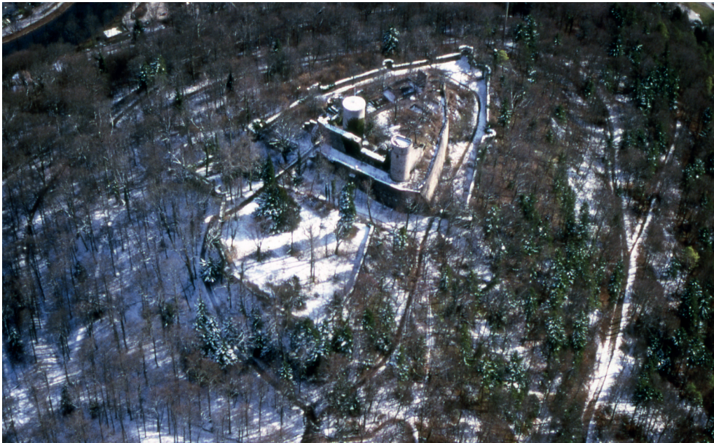
Luftbild des Nagolder Schlossberges mit der Burgruine Hohennagold von Nordwesten. In der oberen Bildhälfte die Hauptburg, von dieser durch einen Halsgraben getrennt der „Turniergarten“ in der Bildmitte. Unterhalb des „Turniergartens“ verlaufen die vermutlich vorgeschichtlichen Wallreste.
