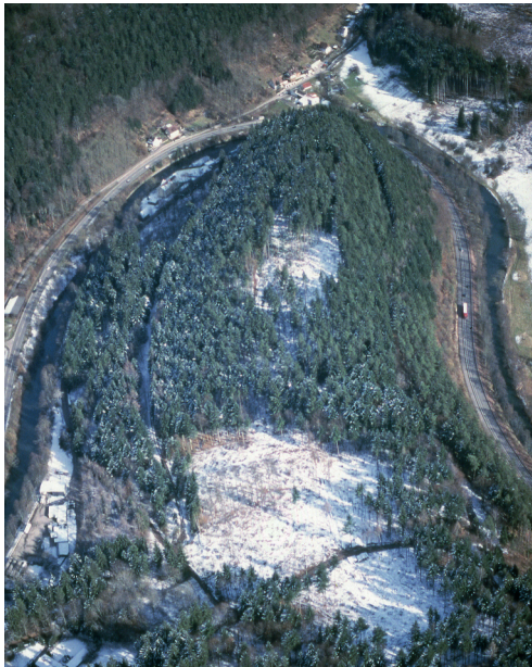
Der Rudersberg in der Nagoldschleife bei Calw von Westen. Die archäologischen Untersuchungen erfolgten im Bereich der kleinen Lichtung (Windbruchfläche) im oberen Bild Drittel.
