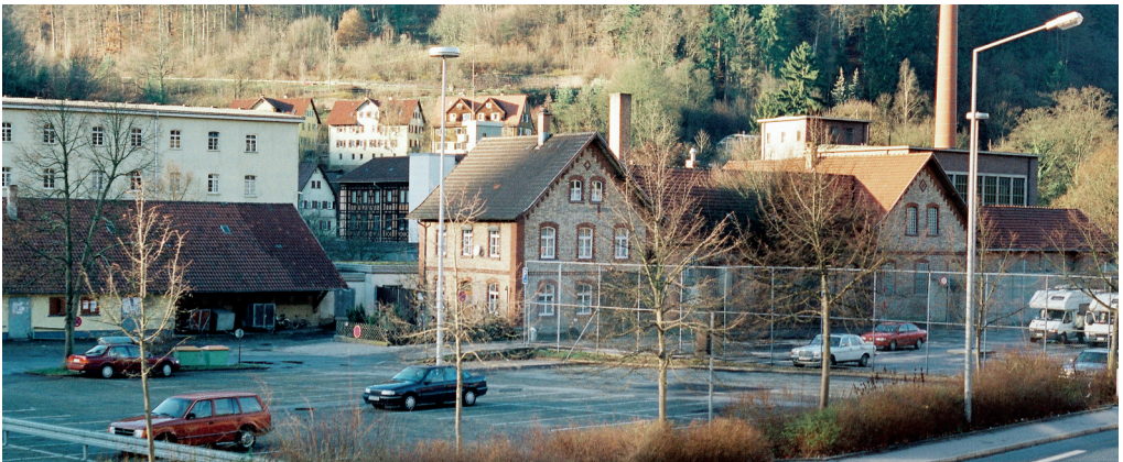
Calwer Schlachthof; 30. Dezember 1997 Viehstallung, Verwaltungsgebäude mit Labor, Schweineschlachthalle, Auslieferungshalle, Gebäude mit Kühlraum (v. l.)
