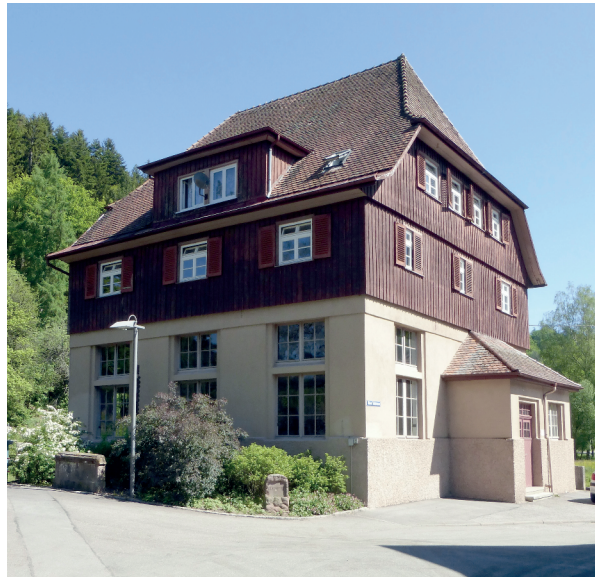
Altensteig – E-Werk 2, Zustand 2014
