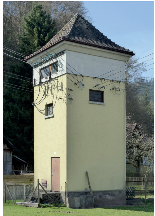
Bad Wildbad-Calmbach, Trafostation von 1931
