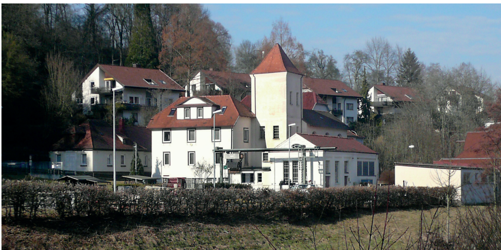
Nagold - E-Werk C. Klinglers Erben, Zustand 2014
