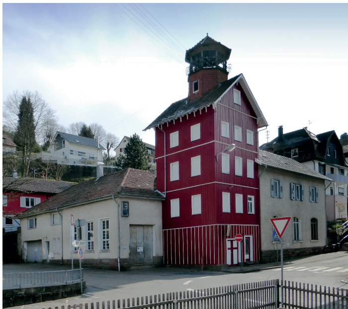
Bad Wildbad – E-Werk 1, mit ehem. Steigerhaus-Turm von 1877
