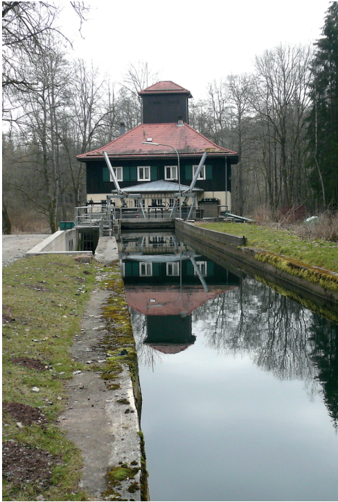
Altensteig-Bernecke – E-Werk 4, Zustand 2014
