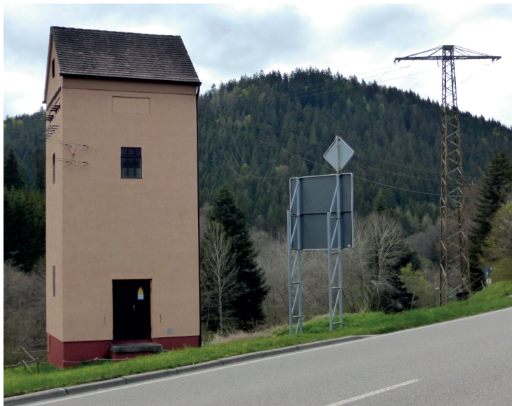
Neuweiler-Agenbach, Gittermast und Trafostation, beide 1930er Jahre
