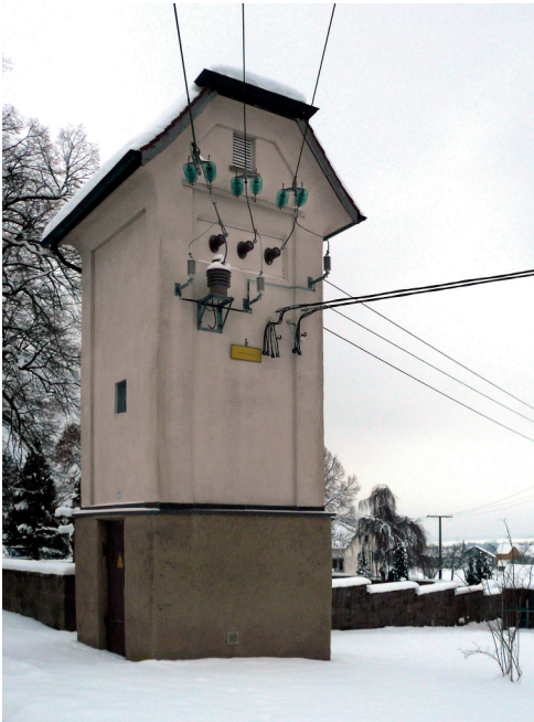
Altensteig-Überberg, Trafostation von 1910
