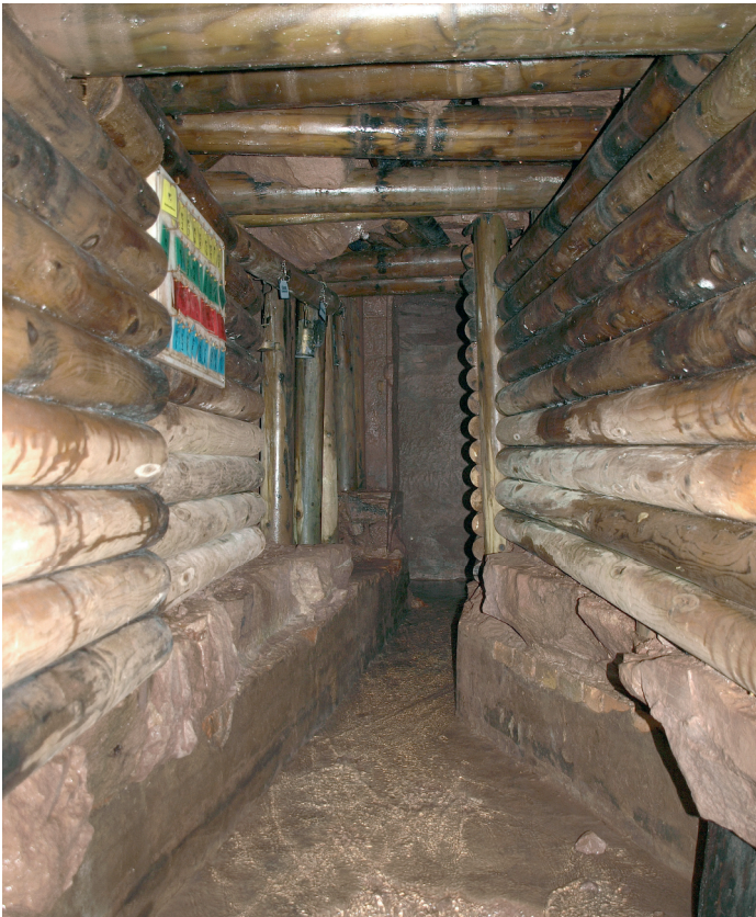
Die ersten Meter der Führungen durch die „Unteren Stollen“ des Besucherbergwerks Neubulach führen im ehemaligen Kanal von der Wasserfassung im Wasserstollen zur ehemaligen Brunnenstube entlang, durch den auch heute noch ein Teil des Wassers aus dem Wasserstollen abfließt.
