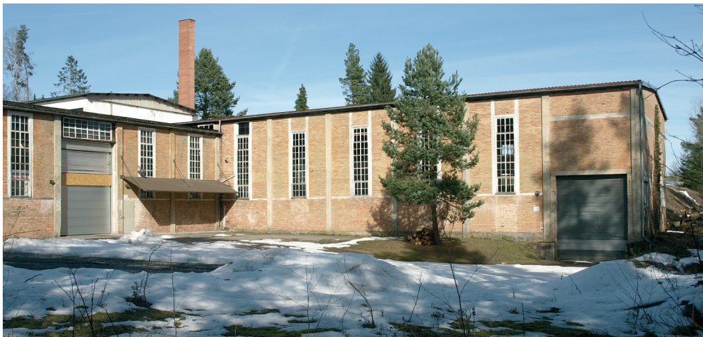
Die heute noch weitgehend erhaltenen Gebäude der Aufbereitungsanlagen in Neubulach wurden zwischen 1942 u. 1945 errichtet, als man nochmals plante, die Restgehalte an Wismut, Kupfer und Silber aus den jahrhundertealten Halden zu gewinnen.
