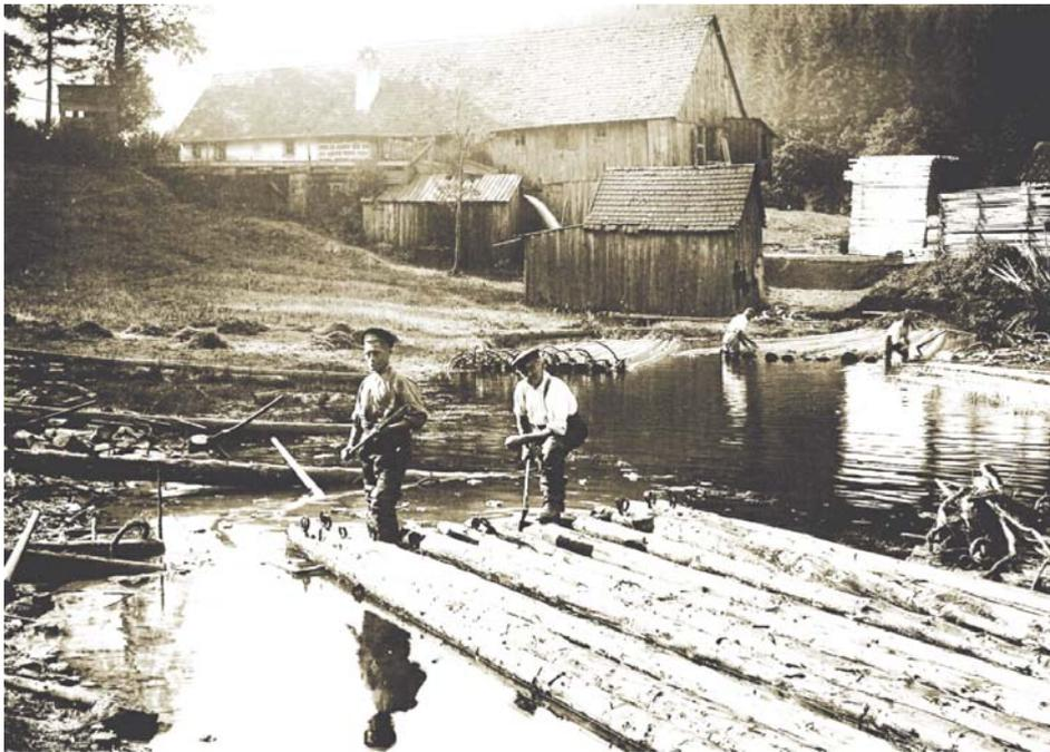
*In der Wasserstube, der „Floßfabrik“ bei der Agenbacher Sägemühle im Kleinenztal laufen die Einbindearbeiten.*
