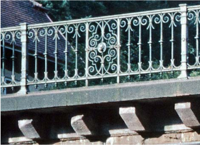
Bild 14. Brückengeländer von 1996 mit den statisch nicht ausreichenden Pfosten. Die Füllungen mit Löwenköpfen blieben bei der Sanierung 2009 erhalten. Die Konsolsteine, die der Brücke eine schöne Gliederung gaben, von denen aber viele abbrachen, sind bei der Brückensanierung durch die 40 cm hohe rot eingefärbte auskragende Fahrbahnplatte (Bild 15 u. 16) ersetzt worden.
