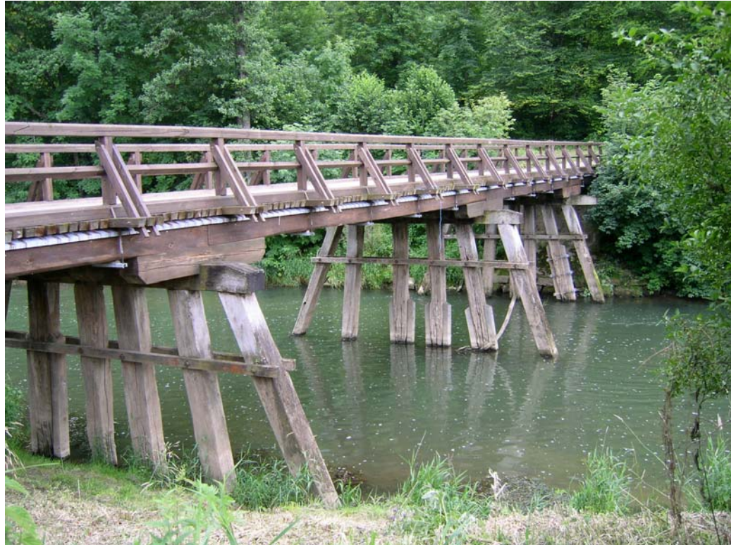
Bild 4. Pfahljochbrücke bei Neckarhausen
