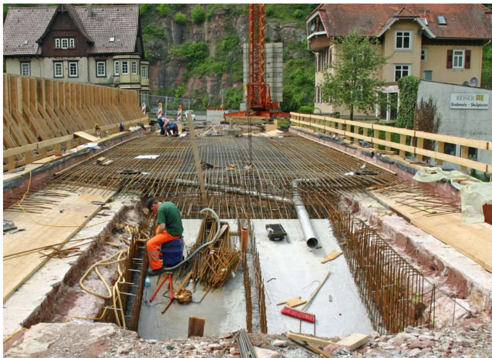
Bild 18. Im Vordergrund liegt in der Vertiefung (Spandrillhohlraum Bild 16) zwischen dem Mauerwerk die neue Betonplatte auf dem Traggewölbe. Dahinter liegt die rechts und links auskragende Bewehrung der Fahrbahnplatte, die in einem zweiten Betonierabschnitt auch über dem Vordergrund aufgebracht wurde.
