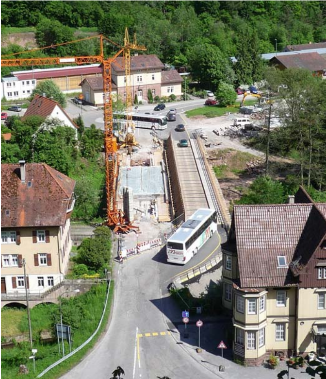
Bild 17. Während der Brückensanierung 2009 bestand oberstromseitig eine Behelfsbrücke (Interimsbrücke).
