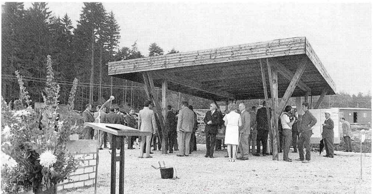
Abb. 3: Grundsteinlegung der Landeslinik Nordschwarzwald am 10.07.1970
