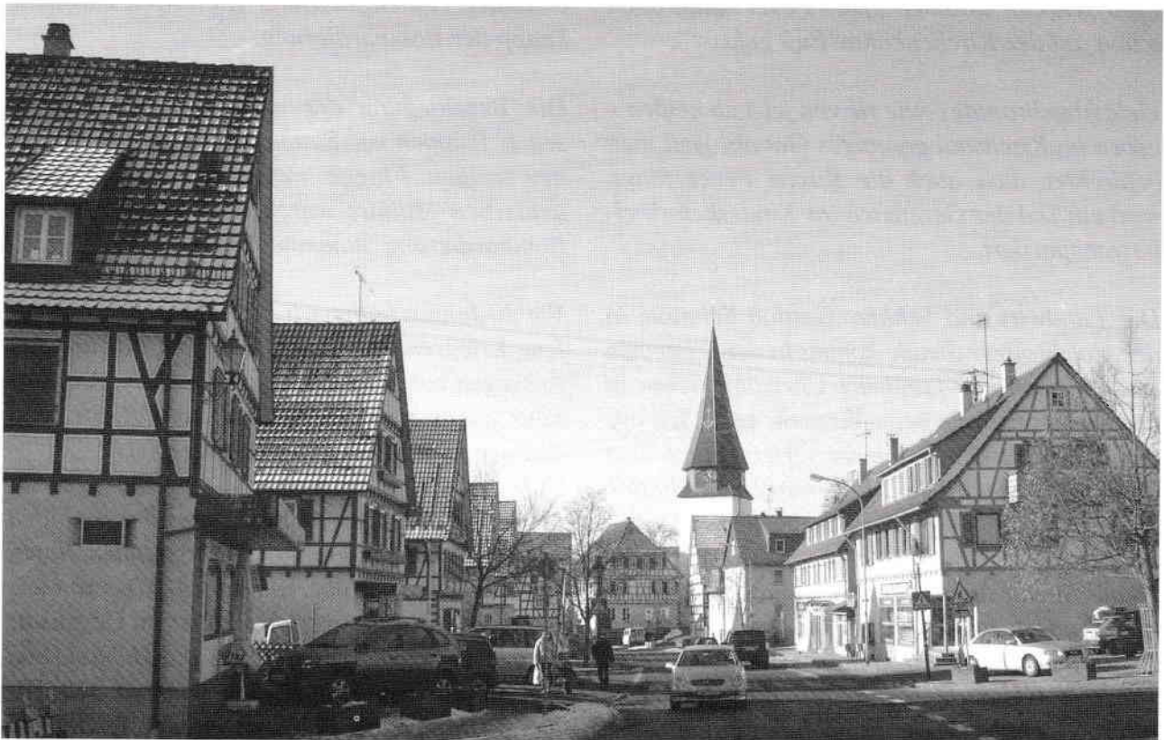
Gleicher Standpunkt, gleicher Blick zur Martinskirche, 2006. Von den oben abgebildeten Häusern stehen nur noch die beiden letzten Häuser vor der Kirche. Rathaus und Brunnen fehlen, die anderen Häuser sind nach der Zerstörung in veränderter Form wieder aufgebaut worden.
