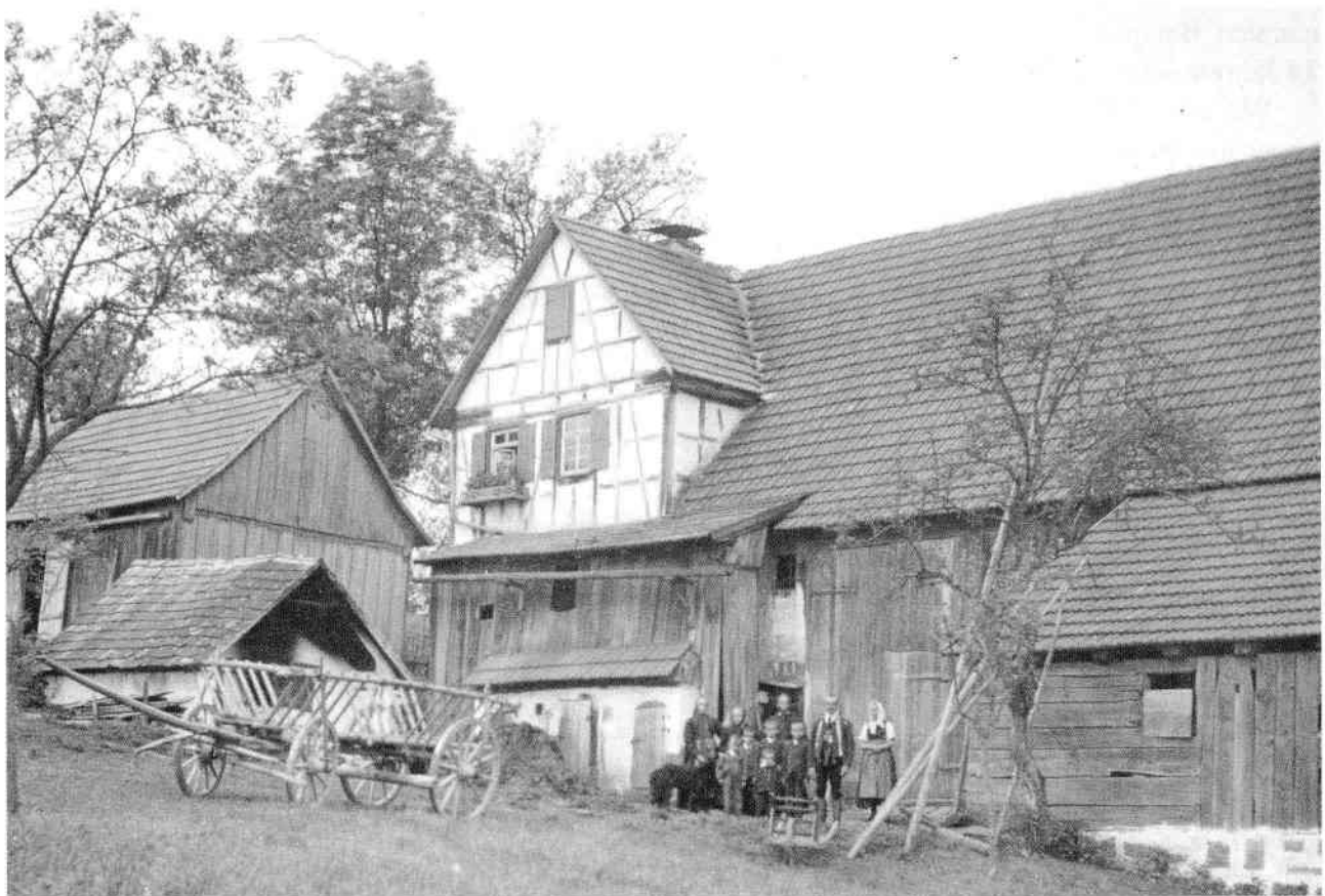
Bild 12 Bildbeschreibung: Aufnahme des Stahlbauernhofs um 1900? Links große Kellerhütte mit offenem Tor, unter ihr ein gewölbter Keller, davor das Backhaus ohne Kamin mit Öffnung am Giebel, Leiterwagen mit hochstehender Deichsel, deshalb für Pferdegespann. Wohnhaus mit Zwerchgiebel und unverschaltetes Holzfachwerk, der Holzvorbau ist der überdachte Treppenaufgang zur Haustür, er wie auch die Kellerhütte besitzen Holzdachrinnen auf zwei Konsolen, vor dem Treppenaufgang Misthaufen und Türen zu den Schweineställen? Gegenüberliegend nicht sichtbar der Viehstall. Vor dem Scheuertor rechts die Eltern, fünf Kinder, Magd? Großmutter? oder Besucher? Der Vater trägt mit Metallknöpfen verzierte Jacke, vor ihm ein Bährenkarren (von Bahre), die große Kamin- (Schornstein) Regenabdeckplatte deutet auf einen aufgesetzten innen besteigbaren Kamin. Bis auf das Backhäusle, das noch mit Handstrichbibern gedeckt ist, tragen die Gebäude bereits Falzziegel. In der Calwer Zeitung gab es dafür erstmals um 1899 Werbeanzeigen. Der erste Falzziegel wurde 1881 hergestellt.
