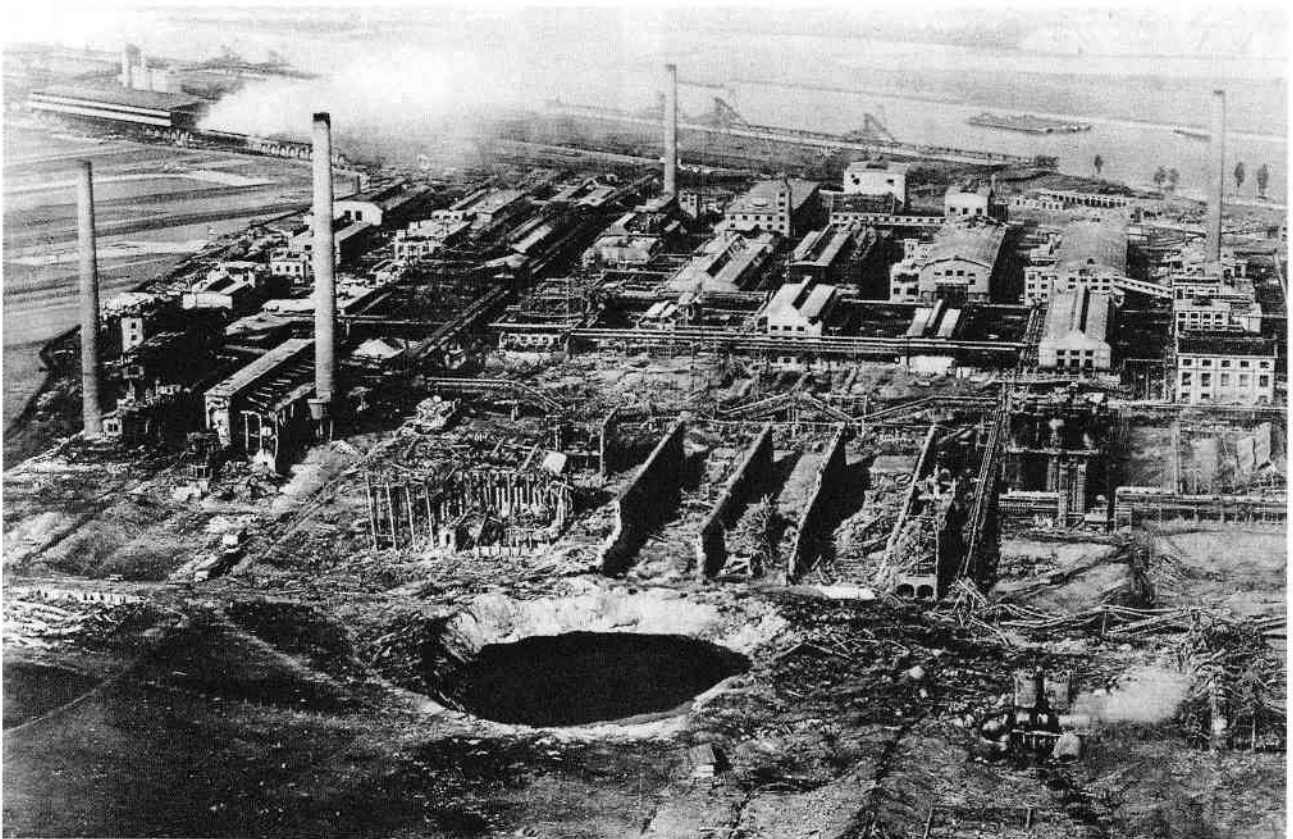
Der mit Grundwasser gefüllte Explosionskrater und das zerstörte Werk Oppau der BASF, Blick von West nach Ost, im Hintergrund der Rhein ( Foto: Unternehmensarchiv der BASF)
