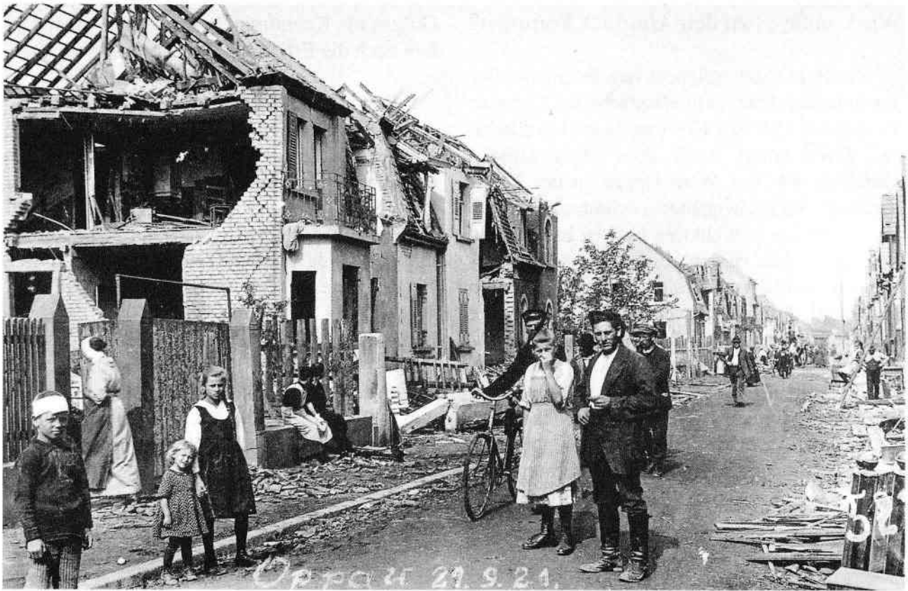
Eine Wohnstraße in Oppau am Tag der Explosion (Foto: Unternehmensarchiv der BASF)
