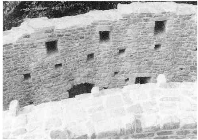
Abb. 21 Westzwinger beim Törchen nach Abschluss der Arbeiten 2001. Im Vordergrund die „Gedenktafelwand“
