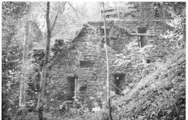
Abb. 26 Schenkelmauer am Südhang mit Schießchartengalerie. Sicherungen aus Hölzern gegen das Auseinanderbrechen, 1995.
