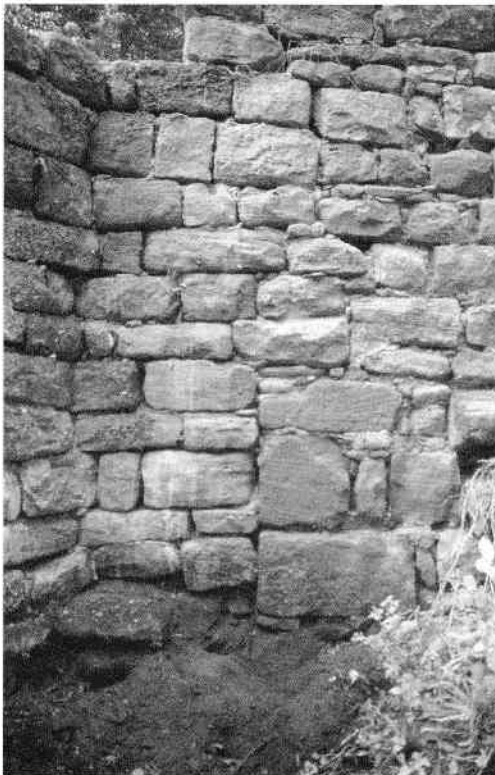
Abb. 24 Ostseite der Wand 25 mit der durchgehenden Fuge unten Mitte. Meist zugewachsen. Rechts unten beginnt die 50 cm breite Kragtreppe.
