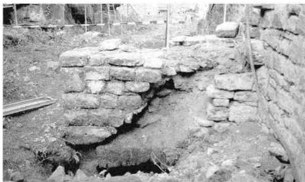
Abb. 16 Der Mauerstummel vor der Renovierung 2001. Unten ist noch der Segmentbogen der Türe als dunkler Streifen zu sehen.
