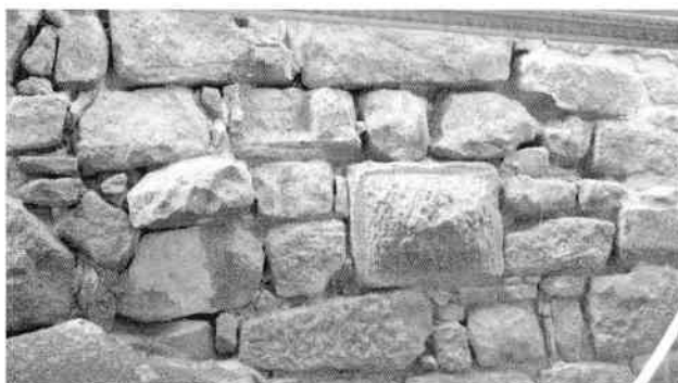
Abb. 17 Nordmauer im Innenhof mit auffallendem Buckelquader und Auflagerstein vor dem Ausfugen 2001
