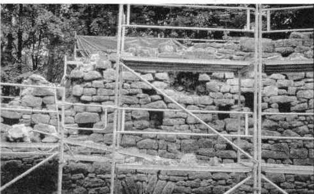
Abb. 20 Westzwinger, beim Neuaufsetzen der zerstörten Mauerkrone.
