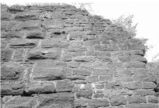
Abb. 31 Südostecke des Bergfrieds. Links Buckelquader, rechts Ausbesserung (Jahr ?) mit kleinformatigen Steinen.
