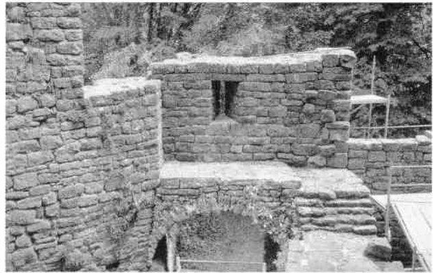
Abb. 22 Blick auf den „Torturm ohne Turm“ mit seinen Rätseeln. Stand die vierte Wand des „Turms“ davor? In der linken Wandhälfte wird eine frühere Öffnung vermutet.
