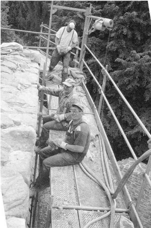
Abb.6 Auskratzen der Fugen. Im Hintergrund ein Bauaufzug. 2001
