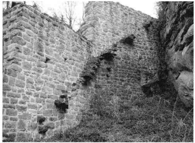
Abb. 25 Die Kragtreppe führte zum Wehrgang (Q) hoch. Zum Felsplateau (Q1) fehlt das Podest.
