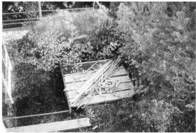
Abb. 32 Blick auf den Bergfried und dessen dichter Bewaldung im Jahr 2000. Mitte: Schutzgerüst im Turmschacht.
