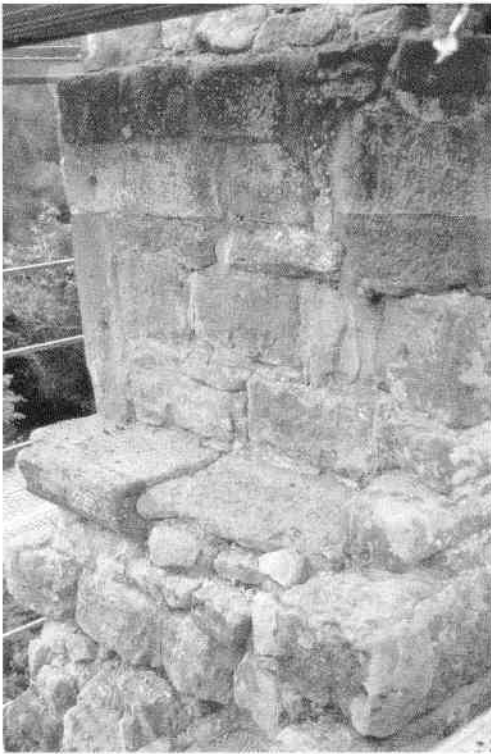
Abb. 36 Sitzbank in der Fensternische auf halber Höhe am östlichen Ende der Palaswand. Blick von Nordost.
