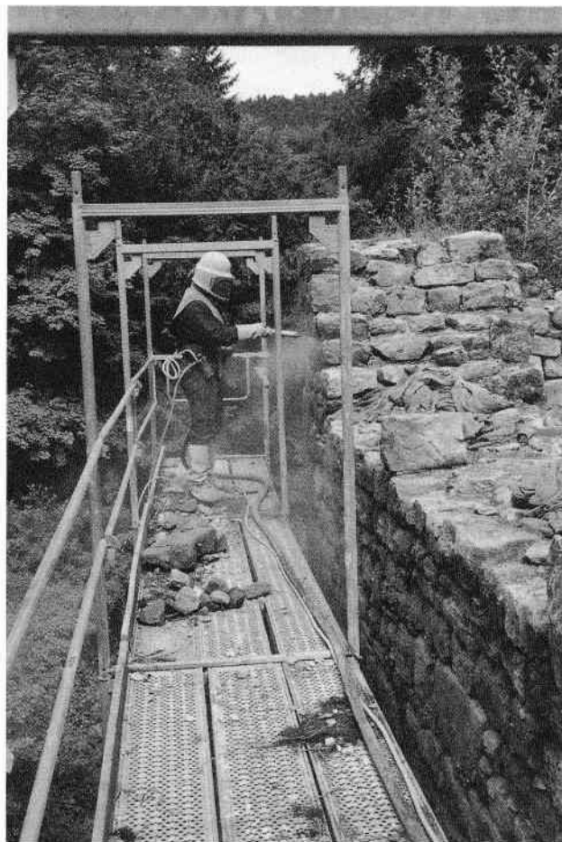
Abb.5 Säubern bzw. Sandstrahlen der Fugen unter Hochdruck. 2001.
