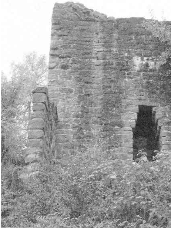
Abb. 34 Bergfried mit der neuen Sperrmauer links von 2001. So schloss die ehemalige viel dickere südliche Palaswand an. Die dunkle Verfärbung rührt vom Regenwasser her. Ist die Öffnung im Bergfried neu?
