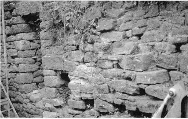
Abb. 18 Westzwingermauer während der Bearbeitung. Von rechts unten nach links oben sind die abgeschlagenen Stufen zu erkennen. 2000 .
