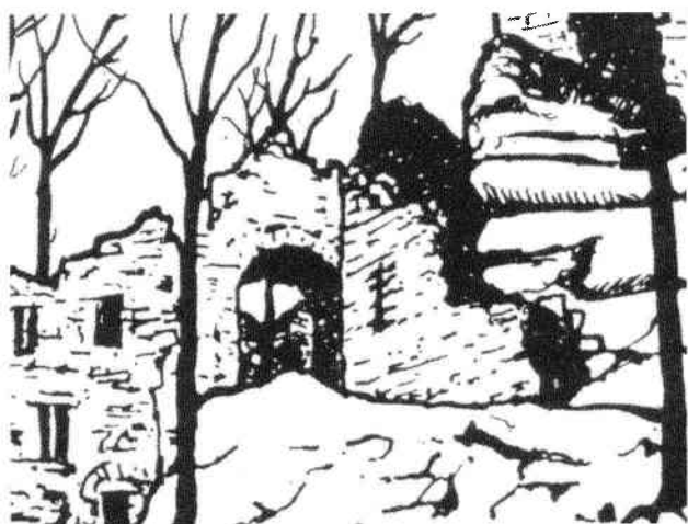
Abb. 28 Das höckerartige originale Mauerwerk am Torturm, ohne Schießscharte! Zeichnung Schwenk, Schramberg, vor 1925, aus Mönch Heimatkunde.
