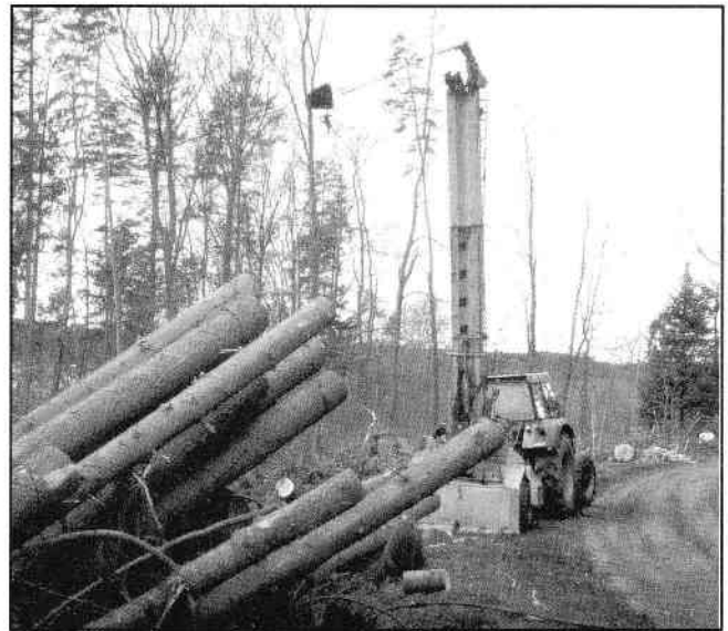
Seilkran mit Laufkatze und Seilturm
