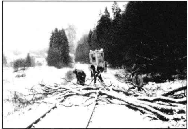
Aufräumarbeiten an der Nagoldtalstrecke
