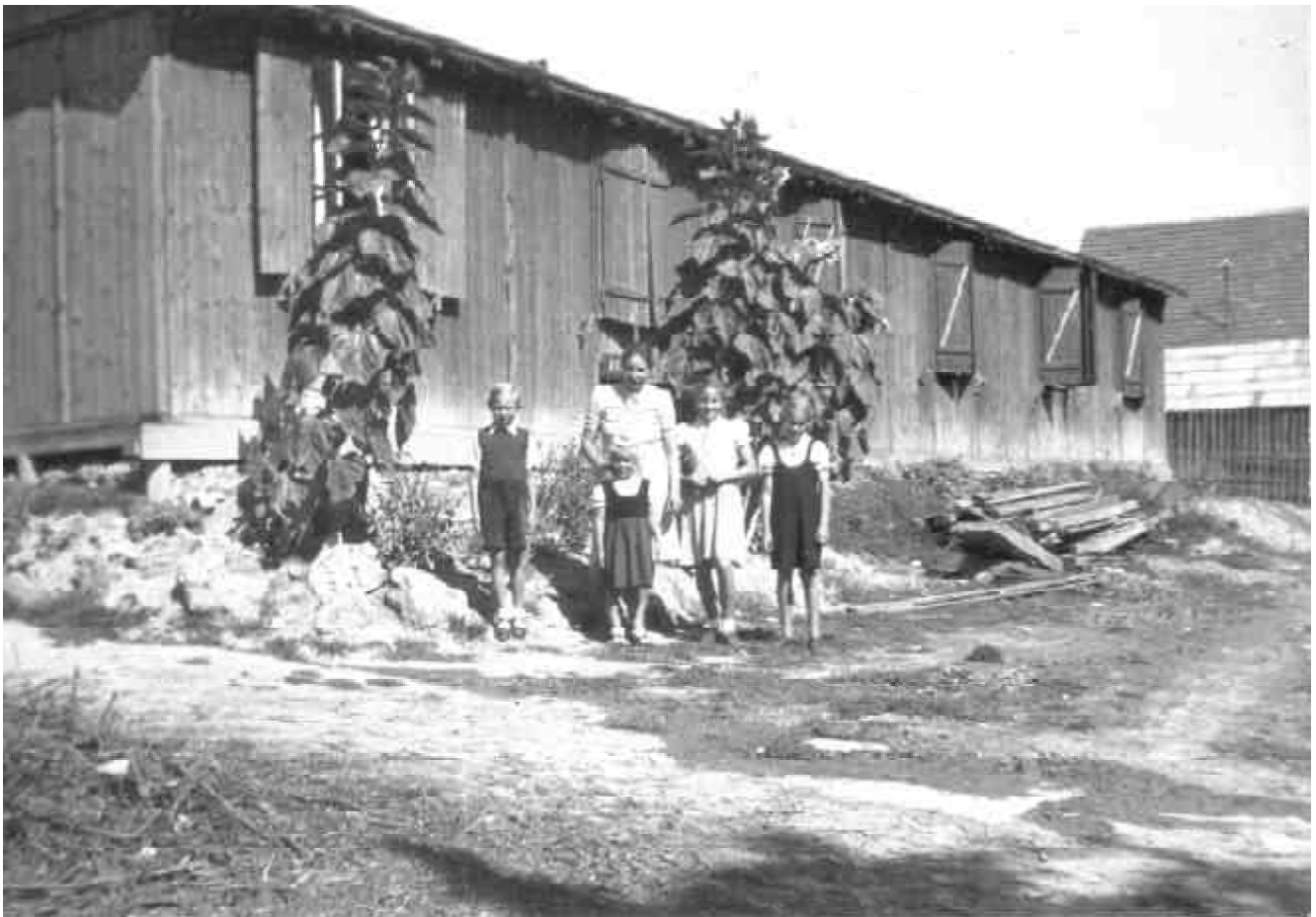
Eine Wohnbaracke mit drei Wohnungen in der Friedensstraße in Stammheim und die Familie Kuonath, die hier von 1947 bis 1956 wohnte.
