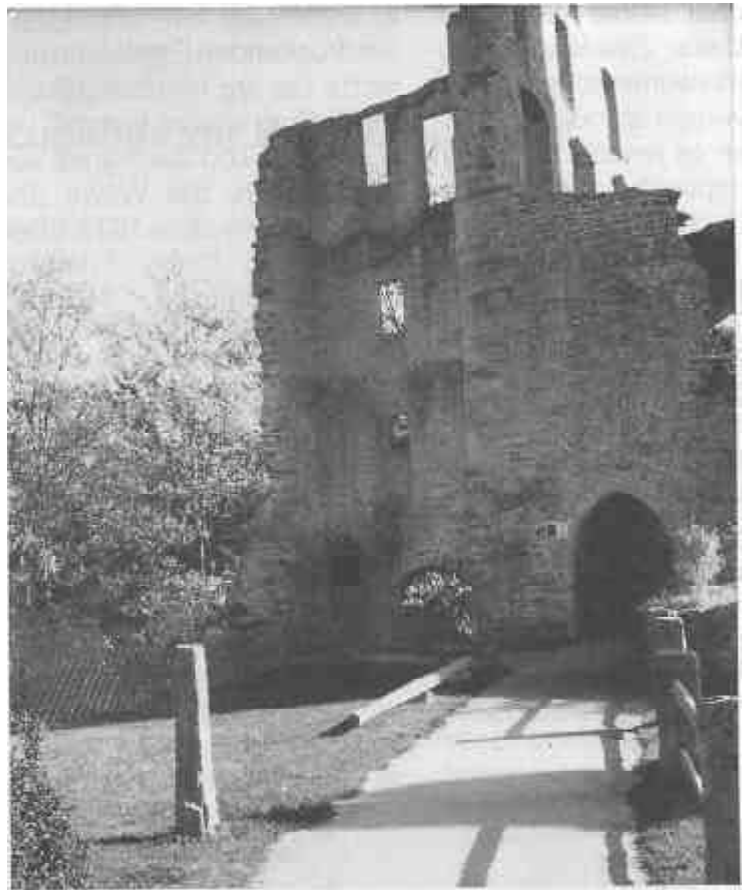
Zugang zur Burg vor der Restaurierung
