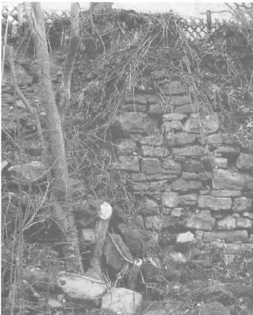
Stadtmauer vor Beginn der Restaurierungen
