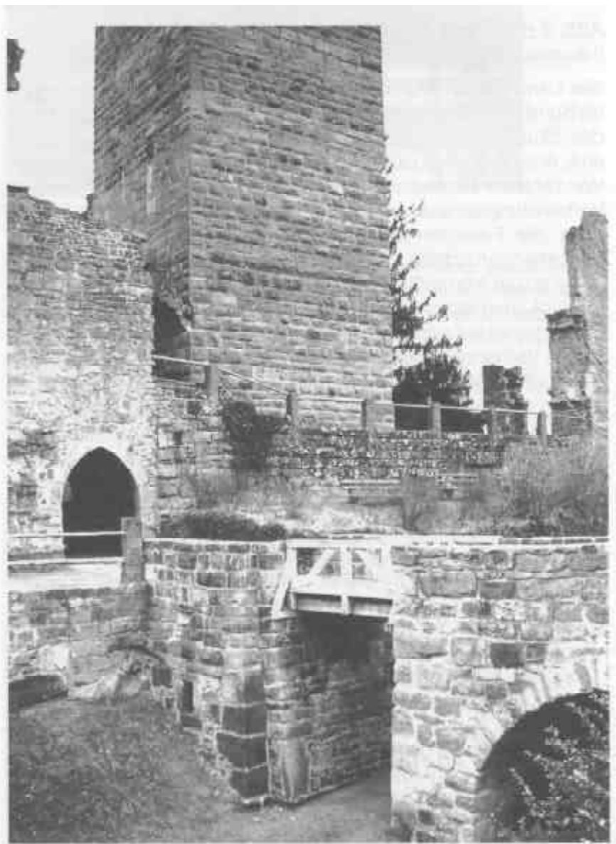
Burgzugang nach Abschluß der Arbeiten
