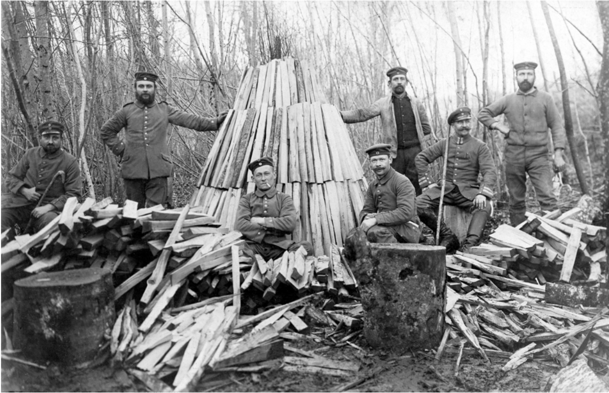
Um den Kamin wird das Holz aufgeschichtet.
