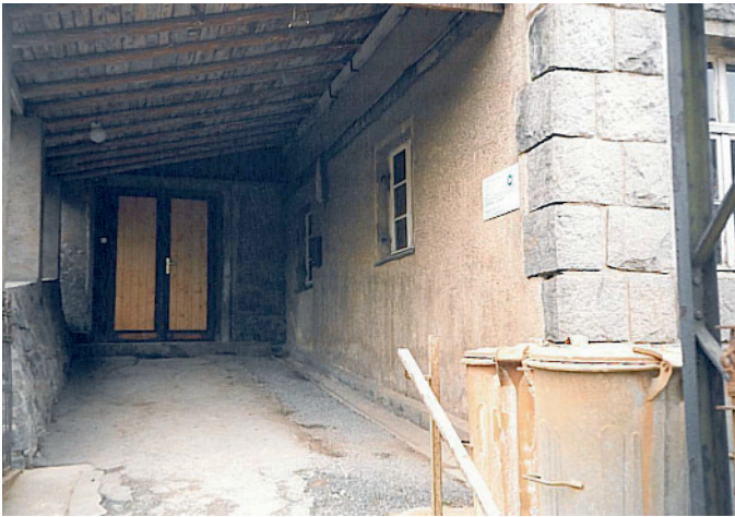
In diesem Gebäude wurde 1991 die Fertigung aufgenommen. Foto: Ehrmann
