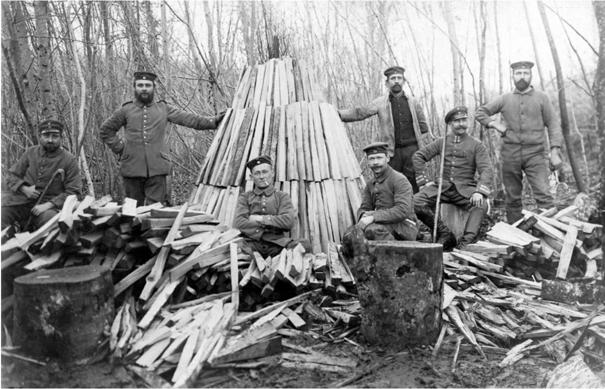
Um den Kamin wird das Holz aufgeschichtet.
