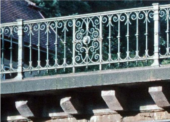
Bild 14. Brückengeländer von 1996 mit den statisch nicht ausreichenden Pfosten. Die Füllungen mit Löwenköpfen blieben bei der Sanierung 2009 erhalten. Die Konsolsteine, die der Brücke eine schöne Gliederung gaben, von denen aber viele abbrachen, sind bei der Brückensanierung durch die 40 cm hohe rot eingefärbte auskragende Fahrbahnplatte (Bild 15 u. 16) ersetzt worden.
