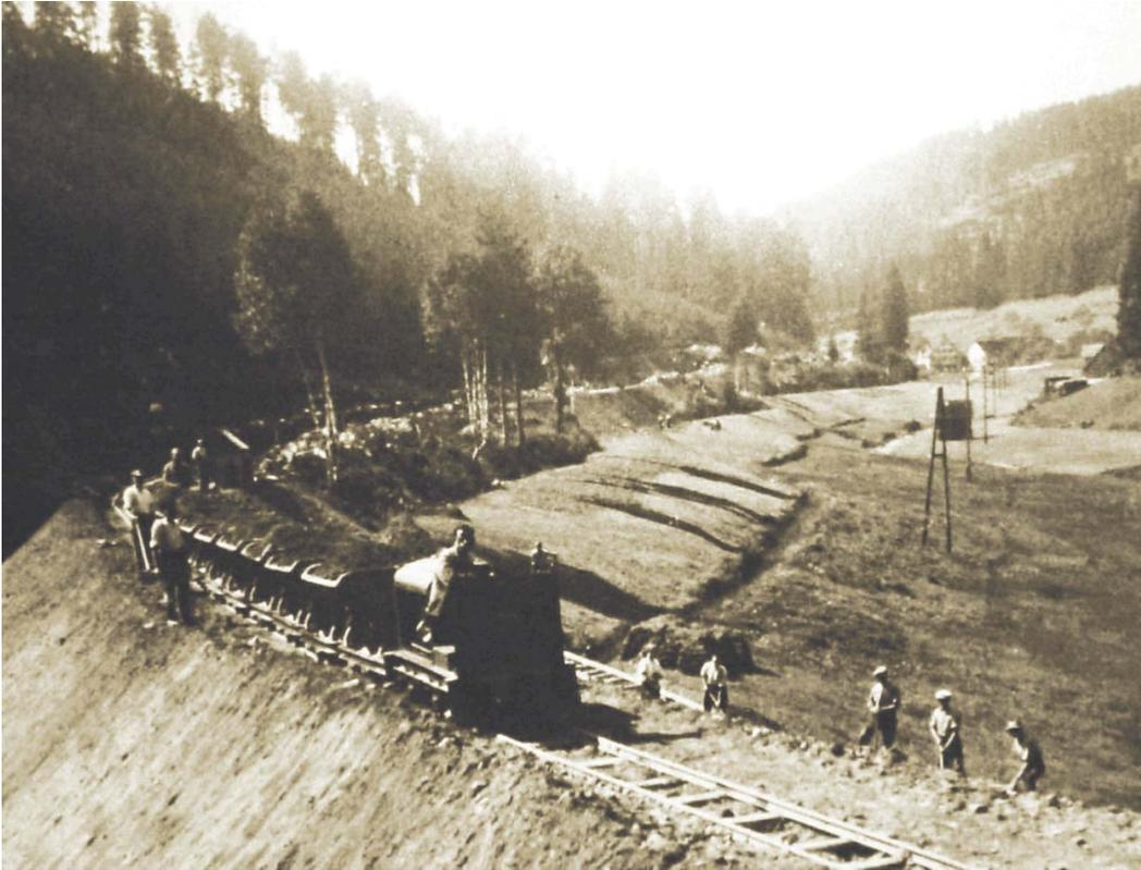
Unterhalb der Rehmühle liefen bald nach 1930 in Notstandsarbeit die Bauarbeiten für die Nachbarschaftsstraße. Der Materialtransport erfolgte mit Hilfe von Loren einer Schmalspurbahn.
