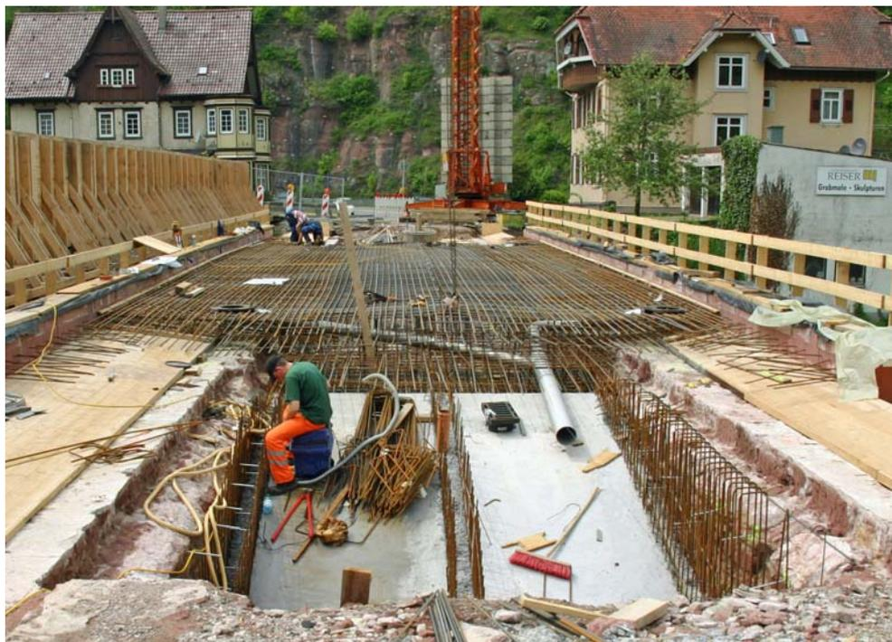
Bild 18. Im Vordergrund liegt in der Vertiefung (Spandriehohlraum Bild 16) zwischen dem Mauerwerk die neue Betonplatte auf dem Traggewölbe. Dahinter liegt die rechts und links auskragende Bewehrung der Fahrbahnplatte, die in einem zweiten Betonierabschnitt auch über dem Vordergrund aufgebracht wurde.
