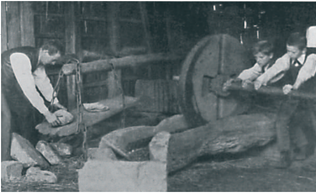
Bild 17: Eine uralte einfache und primitive Konstruktion: Rechts Obstquetsche (Mostrotte) aus Holztrug u. Hölzerner Mahlscheibe. Links kleine Hebelpresse (Baumpresse) mit Brett für Steingewichte, hinten kaum sichtbar der Presstrog. Aus G. Mangold, Mostbuch.
