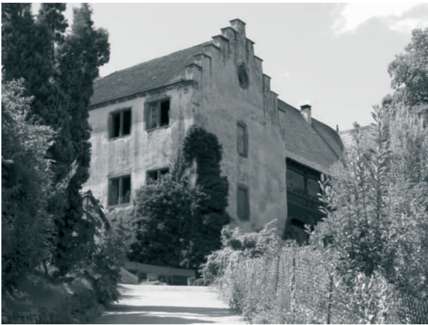
Schloss Unterschwandorf, Teilansicht von Osten
