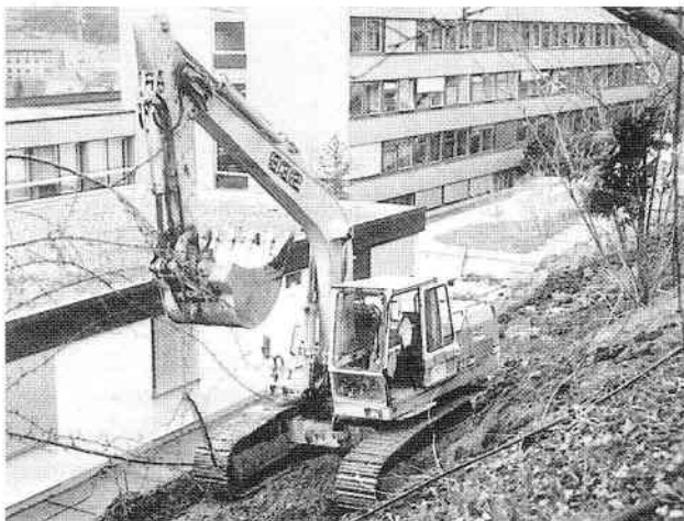
Abb. 7: Bauarbeiten hinter dem Hausmeisterhaus, auf dem der Erweiterungsbau „Haus B“ entstand.
