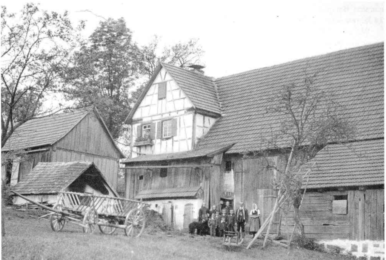
Bild 12 Bildbeschreibung: Aufnahme des Stahlbauernhofs um 1900? Links große Kellerhütte mit offenem Tor, unter ihr ein gewölbter Keller, davor das Backhaus ohne Kamin mit Öffnung am Giebel, Leiterwagen mit hochstehender Deichsel, deshalb für Pferdegespann. Wohnhaus mit Zwerchgiebel und unverschaltetes Holzfachwerk, der Holzvorbau ist der überdachte Treppenaufgang zur Haustür, er wie auch die Kellerhütte besitzen Holzdachrinnen auf zwei Konsolen, vor dem Treppenaufgang Misthaufen und Türen zu den Schweineställen? Gegenüberliegend nicht sichtbar der Viehstall. Vor dem Scheuertor rechts die Eltern, fünf Kinder, Magd? Großmutter? oder Besucher? Der Vater trägt mit Metallknöpfen verzierte Jacke, vor ihm ein Bährenkarren (von Bahre), die große Kamin- (Schornstein) Regenabdeckplatte deutet auf einen aufgesetzten innen besteigbaren Kamin. Bis auf das Backhäusle, das noch mit Handstrichbibern gedeckt ist, tragen die Gebäude bereits Falzziegel. In der Calwer Zeitung gab es dafür erstmals um 1899 Werbeanzeigen. Der erste Falzziegel wurde 1881 hergestellt.
