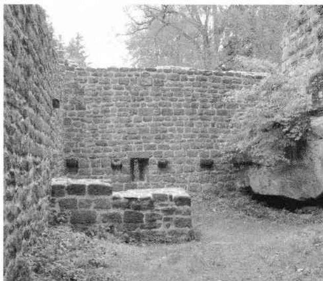
Abb. 14 Der Innenhof mit dem Mauerstummel und Kragsteinen an der Ostwand, nach der Renovierung. Rechts die Palaswand- Außenseite.
