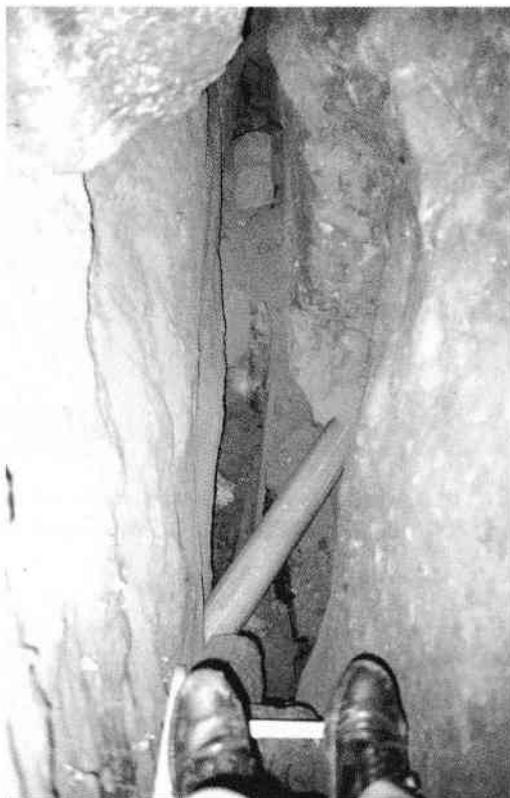
Abb. 13 Blick nach unten auf das Rohr um den Felsanker im Hohlraum einer von mehreren Felsspalten.
