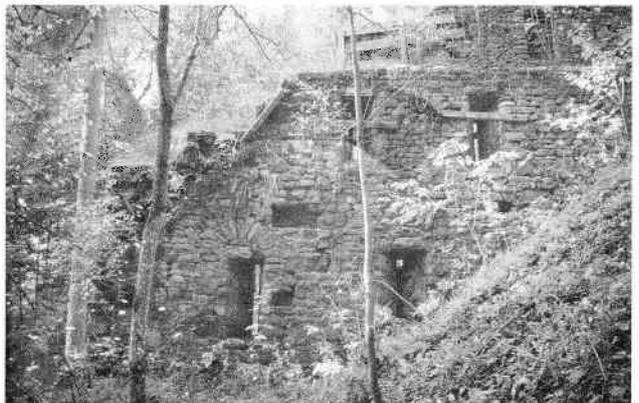
Abb. 26 Schenkelmauer am Südhang mit Schießschartengalerie. Sicherungen aus Hölzern gegen das Auseinanderbrechen, 1995.
