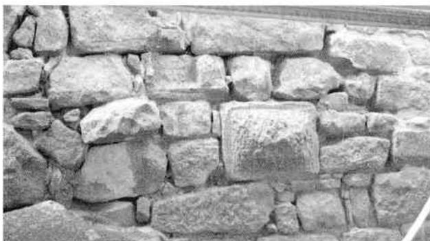
Abb. 17 Nordmauer im Innenhof mit auffallendem Buckelquader und Auflagerstein vor dem Ausfugen 2001
