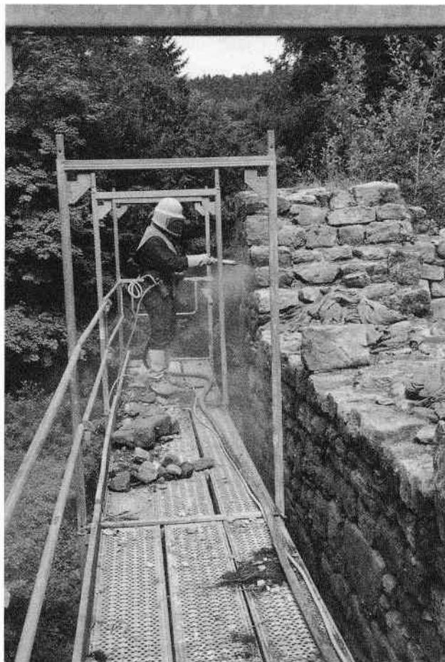
Abb.5 Säubern bzw. Sandstrahlen der Fugen unter Hochdruck. 2001.
