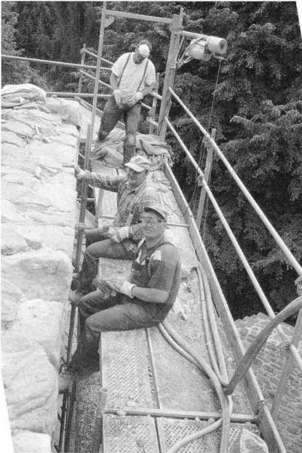
Abb.6 Auskratzen der Fugen. Im Hintergrund ein Bauaufzug. 2001
