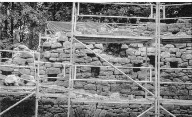
Abb. 20 Westzwinger, beim Neuaufsetzen der zerstörten Mauerkrone.
