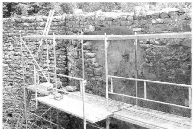
Abb.8 Heruntergefallene äußere Mauerwerksschale hinter dem Gerüst.
