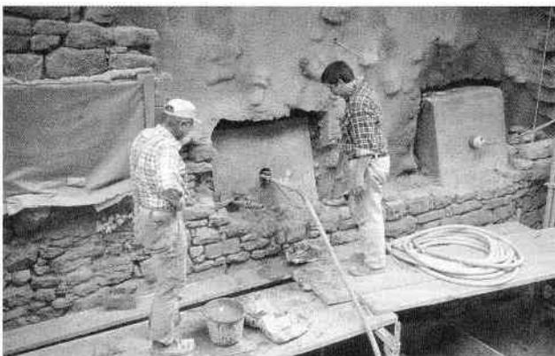
Abb. 11 Am Manometer wird das Fließen des Mörtels durch den Betonquader hindurch überwacht
