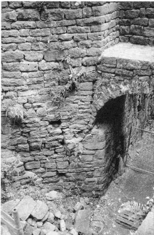
Abb. 23 Linkes Gewölbeauflager des Torturms, das nicht passt. Kragstein Mitte ganz links, darunter unten links vorstehende Mauer, der das Fundament fehlte. War das Gewölbe früher tiefer für ein zweites Tor? Oben Mitte könnte sich der Durchschlupf befunden haben.
