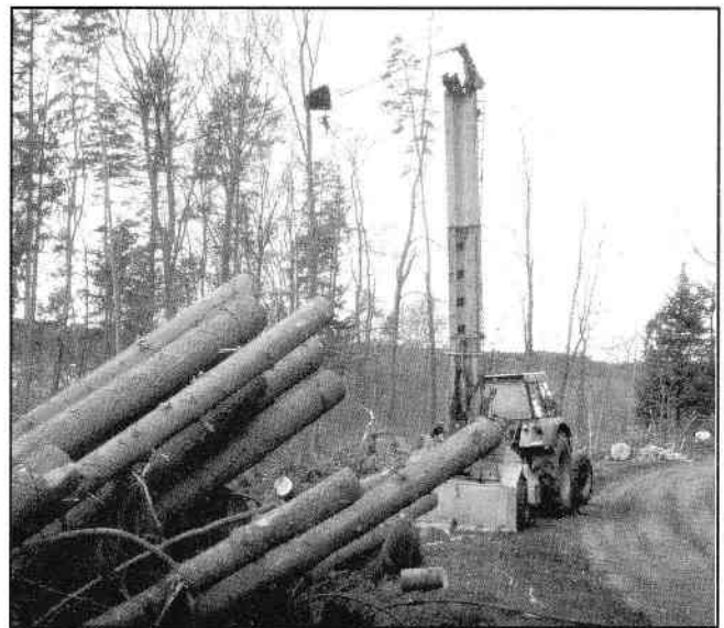
Seilkran mit Laufkatze und Seilturm
