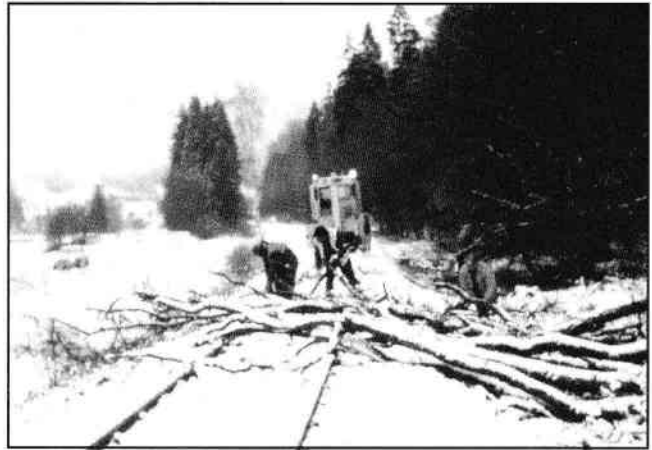
Aufräumarbeiten an der Nagoldtalstrecke
