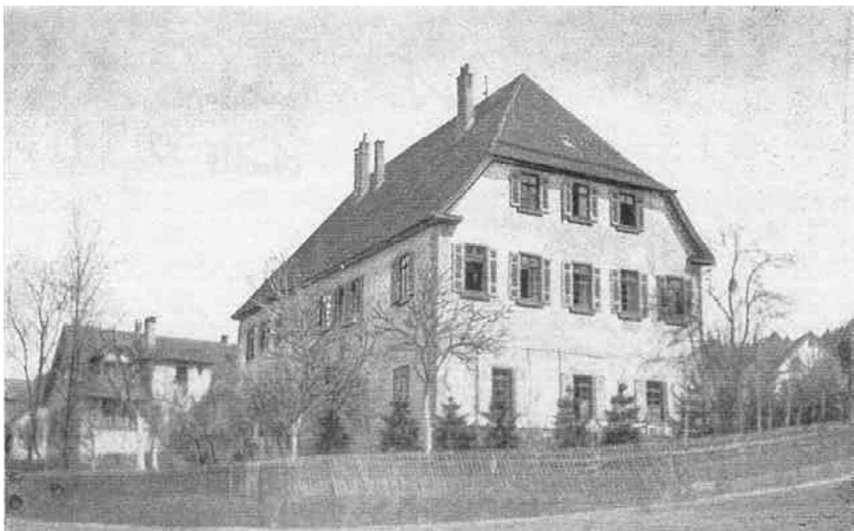
Die Südansicht des heutigen Amtsgerichts mit dem Eingang in der Bahnstraße. Als Zehntscheuer 1799 in Nagold erbaut; 1851 wurde es zum Amtsgericht umgebaut.
