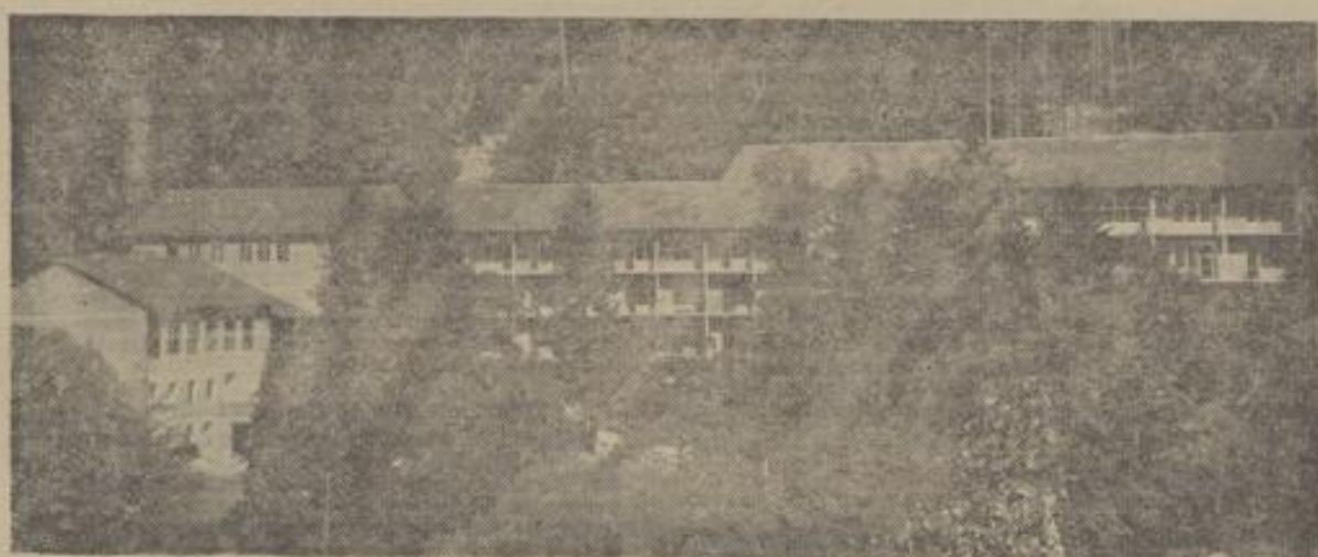
Idyllisch am Südhang hingeblättert wird Haus „Sonnenhalde“ seinem Namen bestimmt alle Ehre machen. Man erkennt die geschickte Aufgliederung des mächtigen Baukörpers. Aufnahme: Stadtmann, Neuenbürg.
