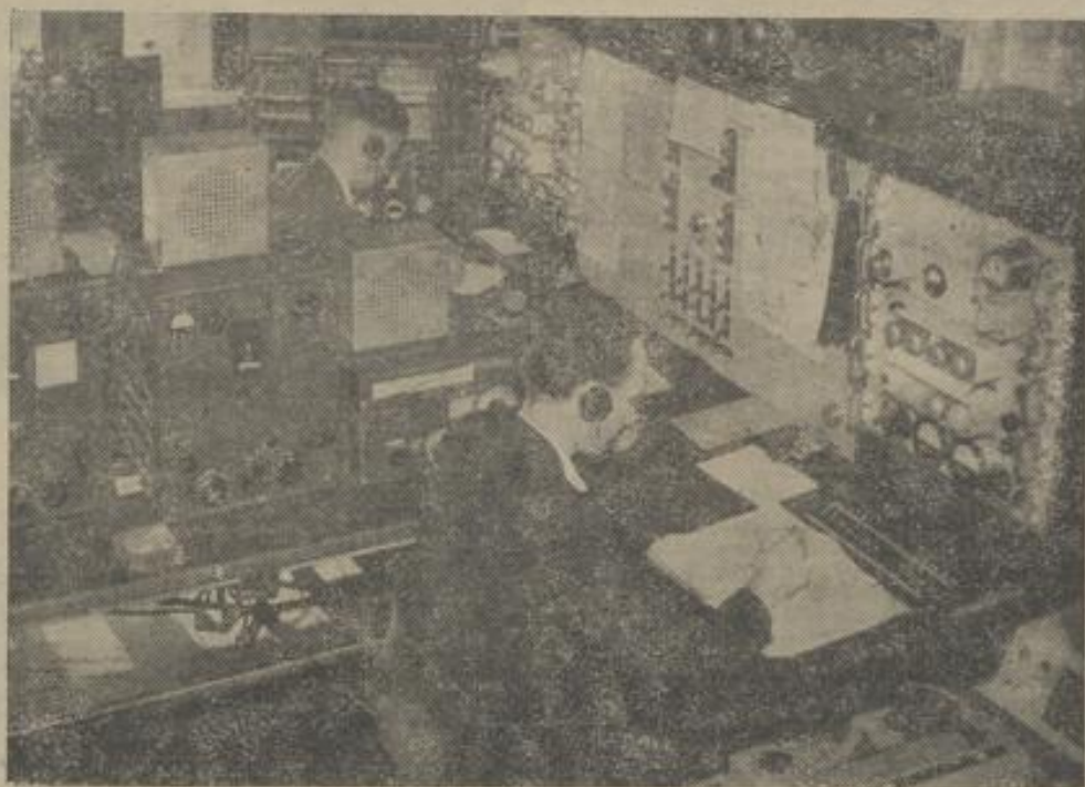
Vom Funktelephonieraum aus werden Seefunkgespräche mit den Schiffen fern von Europa hergestellt sowie Meldungen und Telegramme funktfern-mündlich durchgesagt und aufgenommen. Foto: Meyer-Rodon
