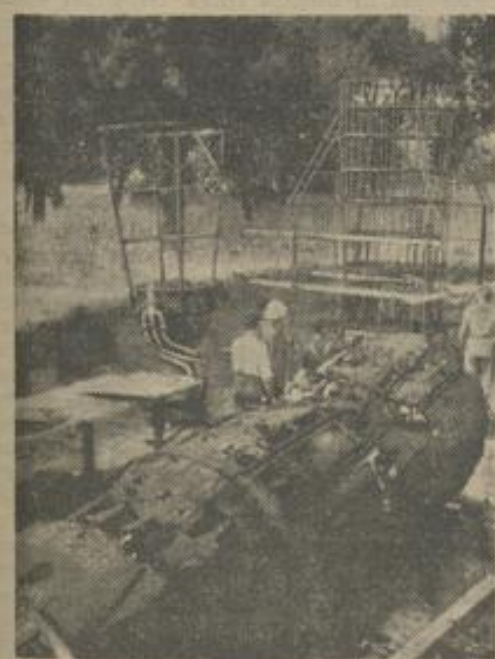
Das ist die letzte „V-2“, die gegenwärtig in Böblingen rekonstruiert wird. Sie soll im Herbst auf einer Ausstellung „Rakete und Raumfahrt“ der Stuttgarter Gesellschaft für Weltraumforschung gezeigt werden. Neben der Rakete das gesondert aufgestellte Triebwerk. Foto: Keystone
