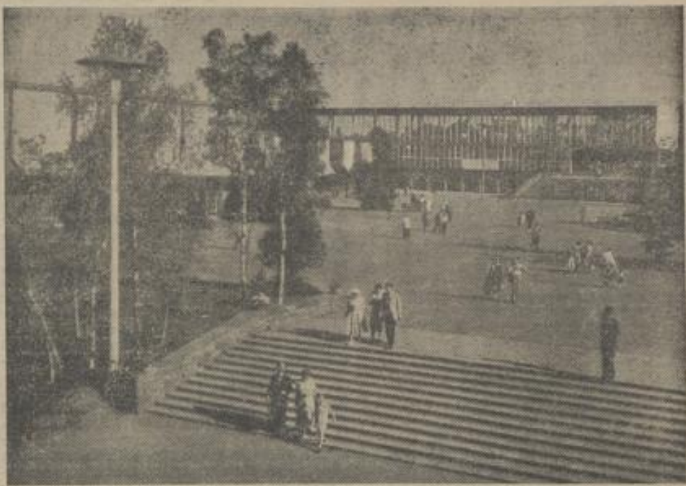
So sieht es jetzt am Haupteingang zum Stuttgarter Killesberg aus (von innen gesehen). Die große Halle im Hintergrund rechts ist erst dieses Jahr gebaut worden. Foto: Windstone
