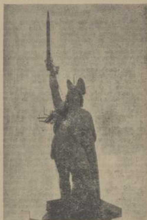
Das durch Fliegerbeschuss und Siegesparaden der einrückenden Besatzung stark beschädigte Hermannsdenkmal im Teutoburger Wald bei Detmold wird zurzeit durch den Berliner Turmspezialisten „Turm-Linde“ ausgebessert. Fast immer nur an Stellen hängend, werden die schwierigen Arbeiten an dem 57 m hohen Denkmal durchgeführt. Die Abnahme des 7 m langen Schwertes, dessen Inschrift „Deutschlands Einigkeit — meine Stärke“ neu vergoldet werden soll, stößt auf besondere Schwierigkeiten, weil das Schwert in Hermanns Hand eingeroastet ist
