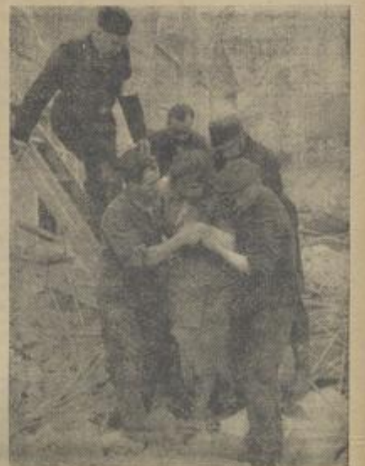
Eine verletzte Arbeiterin wird geborgen
