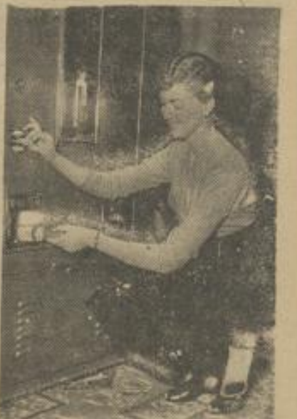
Eingekehrt kommen die Drinks aus diesem neuartigen Automaten, der für Kantinen, Bahnhöfe, öffentliche Plätze usw. gedacht ist. Man wirft ein Geldstück ein, drückt aufs Knöpfchen, dann kommt unten die gewünschte Flasche und oben der zugehörige Strohhalm heraus. Keystone-Bild
