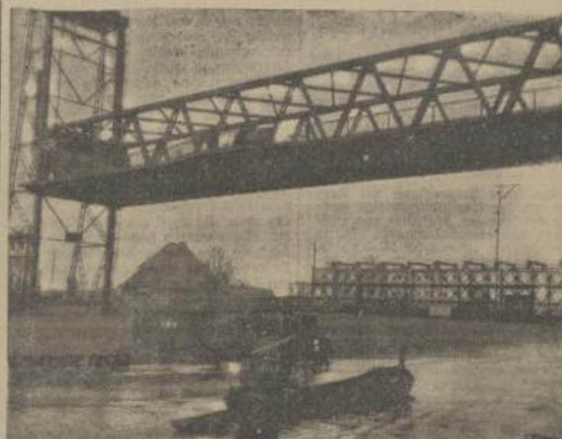
Die zweitgrößte Hubbrücke der Bundesrepublik, die über die Hunte führt, ist in einer Feierstunde dem Verkehr übergeben worden. Die neue Brücke erlaubt es auch größeren Schiffen - bis 2000 BRT - die Stadt Oldenburg anzulassen. Die Gegengewichte an der 30 m hohen und 53 m langen Brücke wiegen je 255 Tonnen. Bild: AP
