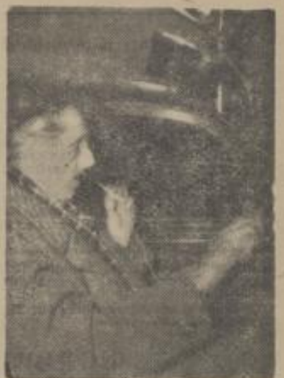
Eine der 380 Neuheiten, die bis 6. Dezember auf der Erfindermesse in Hannover zu sehen sind: Einigarettenartiger Kontakt, den der Autofahrer bei starker Müdigkeit zwischen die Zähne nimmt. Falls er einschläft, lockert sich der Biß, und es ertönt ein Hupsignal. Bild: dpa
