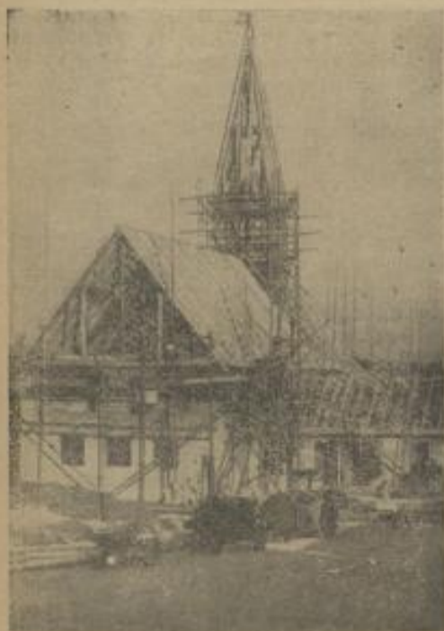
Im Mittelpunkt des Wimbbergs steht die neue Bergkirche, deren Rohbau demnächst die schützende Dachhaube erhält. (Die Dachlattung ist inzwischen bereits angebracht und der Turm eingestrichelt worden.)
