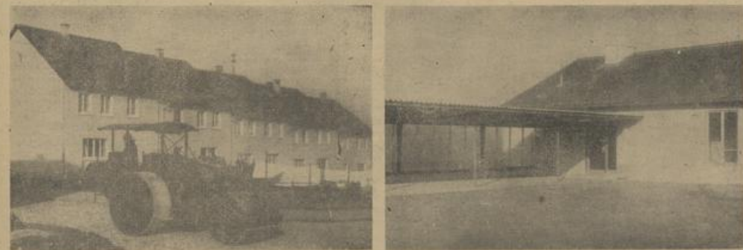
Rund eine halbe Million DM hat die Stadtverwaltung bisher für die Erschließung, Kanalisierung, Wasserversorgung und den Straßenbau auf dem Wimberg ausgegeben. Nun wird auch die Ostlandstraße hergerichtet (dahinter ein 8-Familienwohnblock für Heimatvertriebene). — Rechts: Eingang und Pausenhalle der Wimbbergschule.
