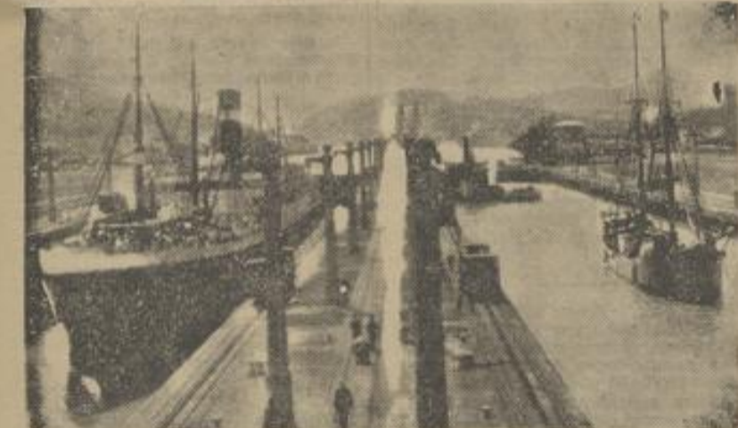
Schleusenbetrieb in der Kanalmitte
