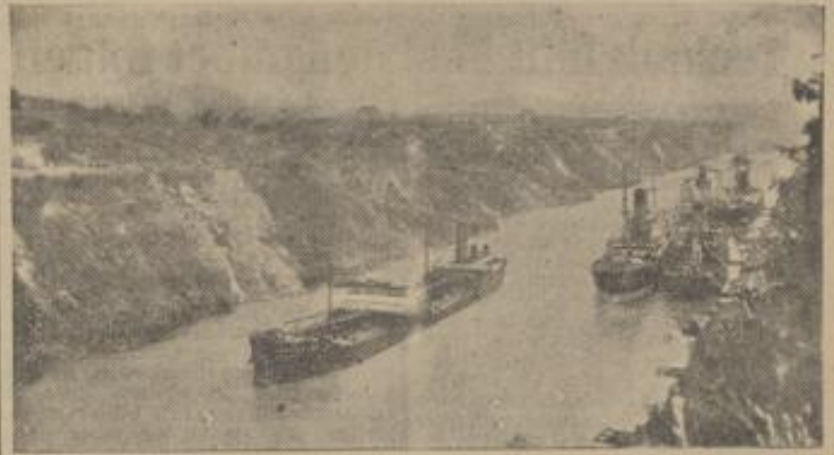
Die 150 m breite Kanalrinne verläuft größtenteils zwischen Bergen und Hügeln
