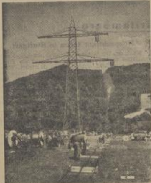
Seilzuarbeiten an einem 50 m hohen Tragmast in der Nähe von Buchenbach. Bild: Richter
