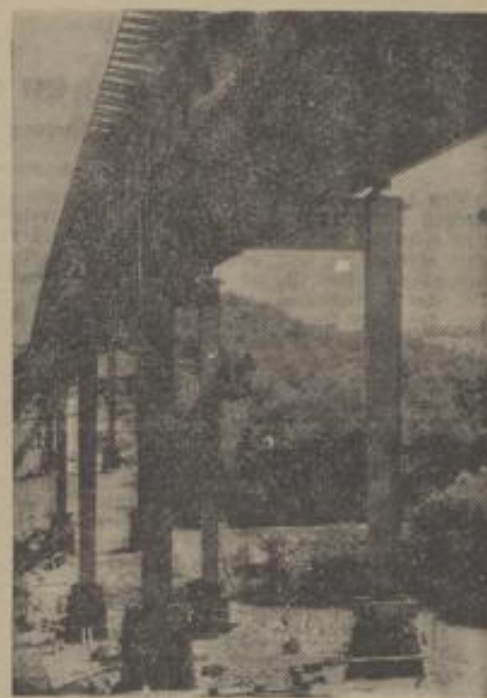
In großem Bogen spannt sich die Eisenkonstruktion des im Bau befindlichen Sulzbach-Viadukts bei Denkendorf, Kreis Eßlingen, über das Tal. Anfang nächsten Jahres soll dieses markante Bauwerk vollendet sein und dem Verkehr übergeben werden. Damit würde sich die letzte Lücke der Autobahn zwischen Stuttgart und München schließen. Bild: dpa
