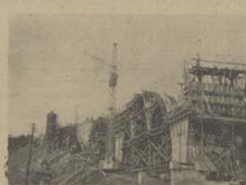
Baustelle von der Talstraße aus
