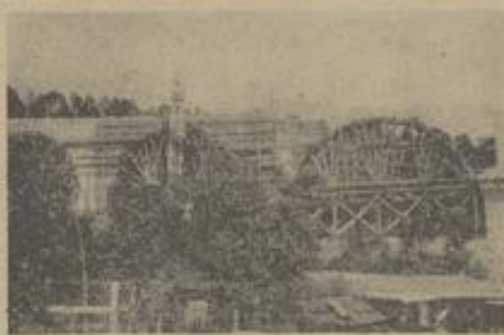
Die drei ersten Bogen des Viadukts
