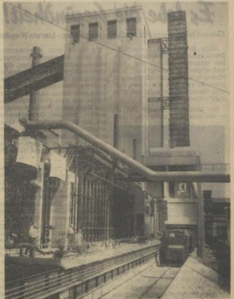
In Berlin-Mariendorf wurde eine der modernsten Gas- und Kokszerzeugungsanlagen Europas in Betrieb genommen.
